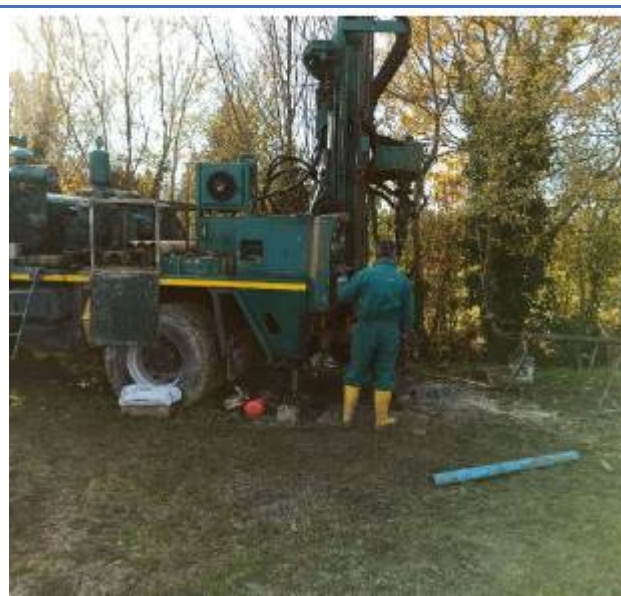
Figura 2.8: Panoramica area piezometro AST02V
