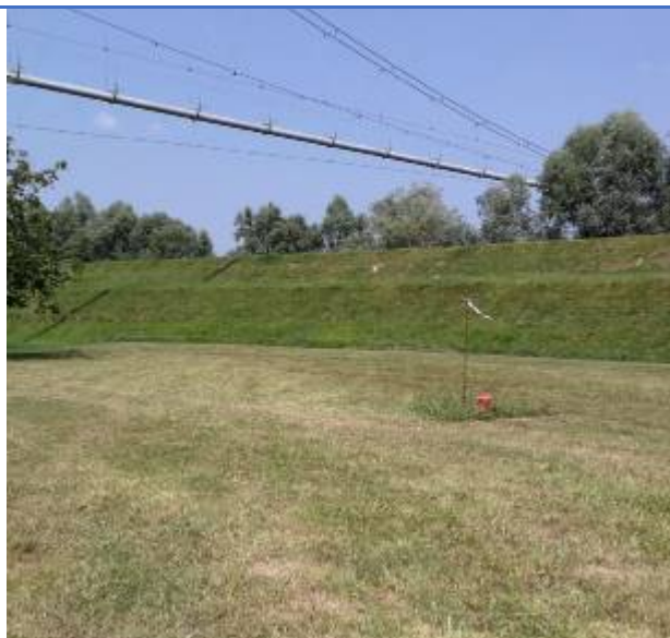
Figura 2.16: Panoramica area piezometro ASt04V
