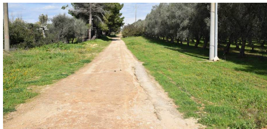
Figura 7 – Strada locale di accesso all'aerogeneratore A05. La strada ha larghezza adeguata e necessita esclusivamente di interventi di livellamento del piano viario atti a eliminare buche e sconnessioni.
