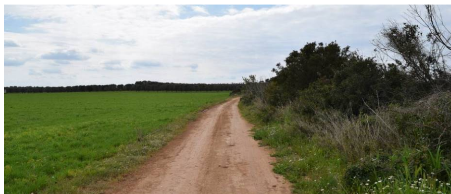
Figura 9: stradina di accesso all'aerogeneratore A07, tratto in partenza dalla SP 145. La stradina ha necessità di essere allargata per consentire il passaggio dei mezzi di trasporto eccezionali.
