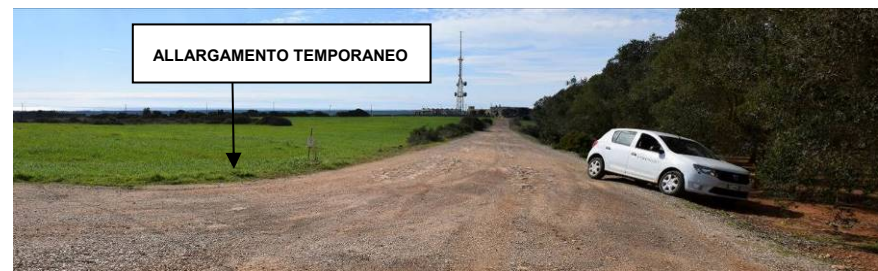
Figura 14 - Imbocco della strada di accesso all'aerogeneratore A03 che necessita di un allargamento temporaneo sulla sinistra e dell'abbattimento di pochi alberi sulla destra.
