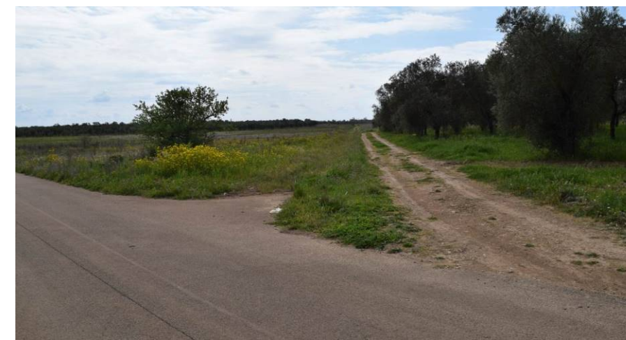
Figura 8: strada di accesso all'aerogeneratore A06. La strada necessita di allargamento della carreggiata mediamente di circa 1,5 metri.
