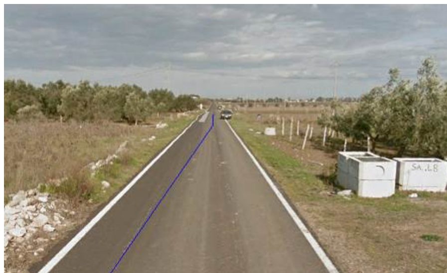
Figura 27– Tratto di strada comunale “Cicarella”. I cavidotti saranno posati lungo il margine di tale strada. Da tale strada si avrà accesso alla SE di Utenza.
