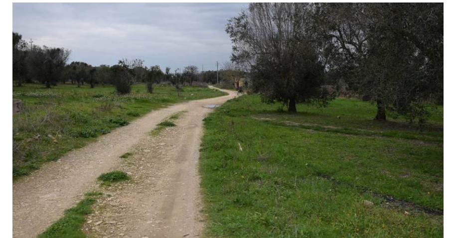
Figura 25- Tratto di strada senza denominazione brecciata. I cavidotti saranno posati lungo il margine di tale strada.
