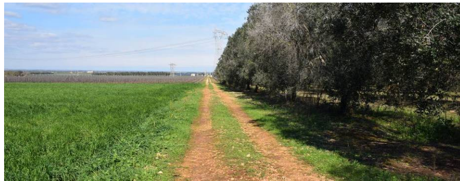
Figura 4 – Ultimo tratto della strada in terra battuta di accesso all'aerogeneratore A01. Come si scorge dalle fotografie, è evidente la necessità di adeguamento della viabilità esistente dal tratto in cui parte la carrareccia esistente dalla strada comunale asfaltata.
