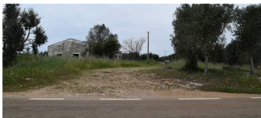
Figura 18 – Imbocco dalla SP219 della strada di accesso al sito di ubicazione dell'aerogeneratore A07 che necessita di allargamento temporaneo.
