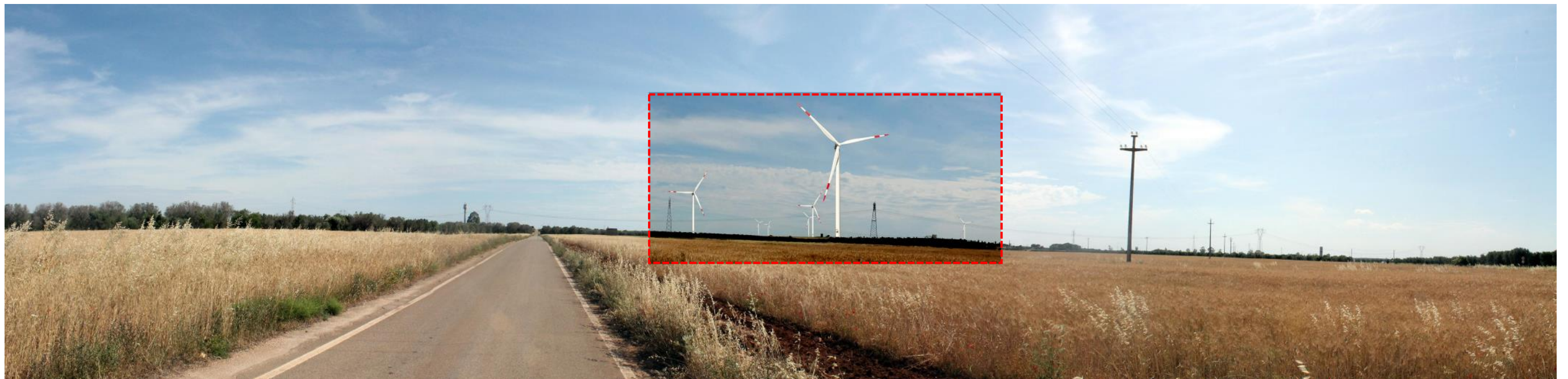
PAN 11 _ Confronto tra stato di fatto (in alto) e progetto _ Vista a circa 800 m di distanza dagli aerogeneratori in progetto (nel riquadro rosso con maschera di evidenziazione)
