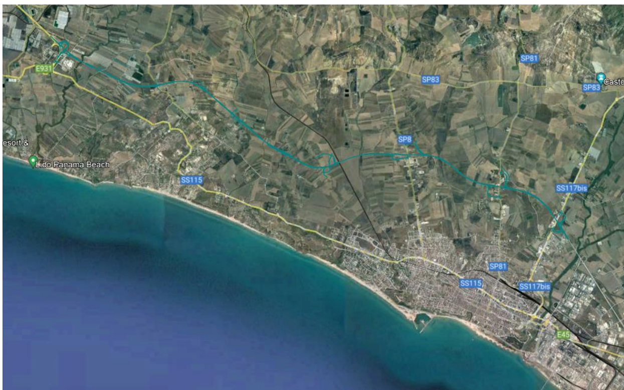
Figura 2-3 – Il territorio interessato dall'intervento in progetto: in giallo la S.S.115 che attraversa il centro abitato di Gela (Fonte: Google Earth).
