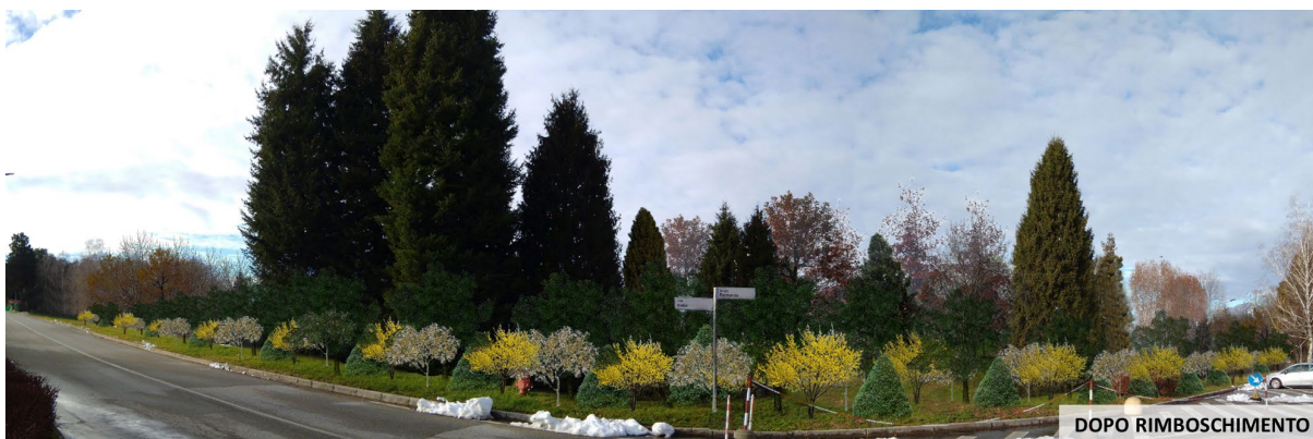
Figura 4-8. PV1 – Panoramica Nord Ovest del Complesso INE dal punto esterno situato ad Est del sito (prima e dopo lo smantellamento, dopo il rimboscimento)
