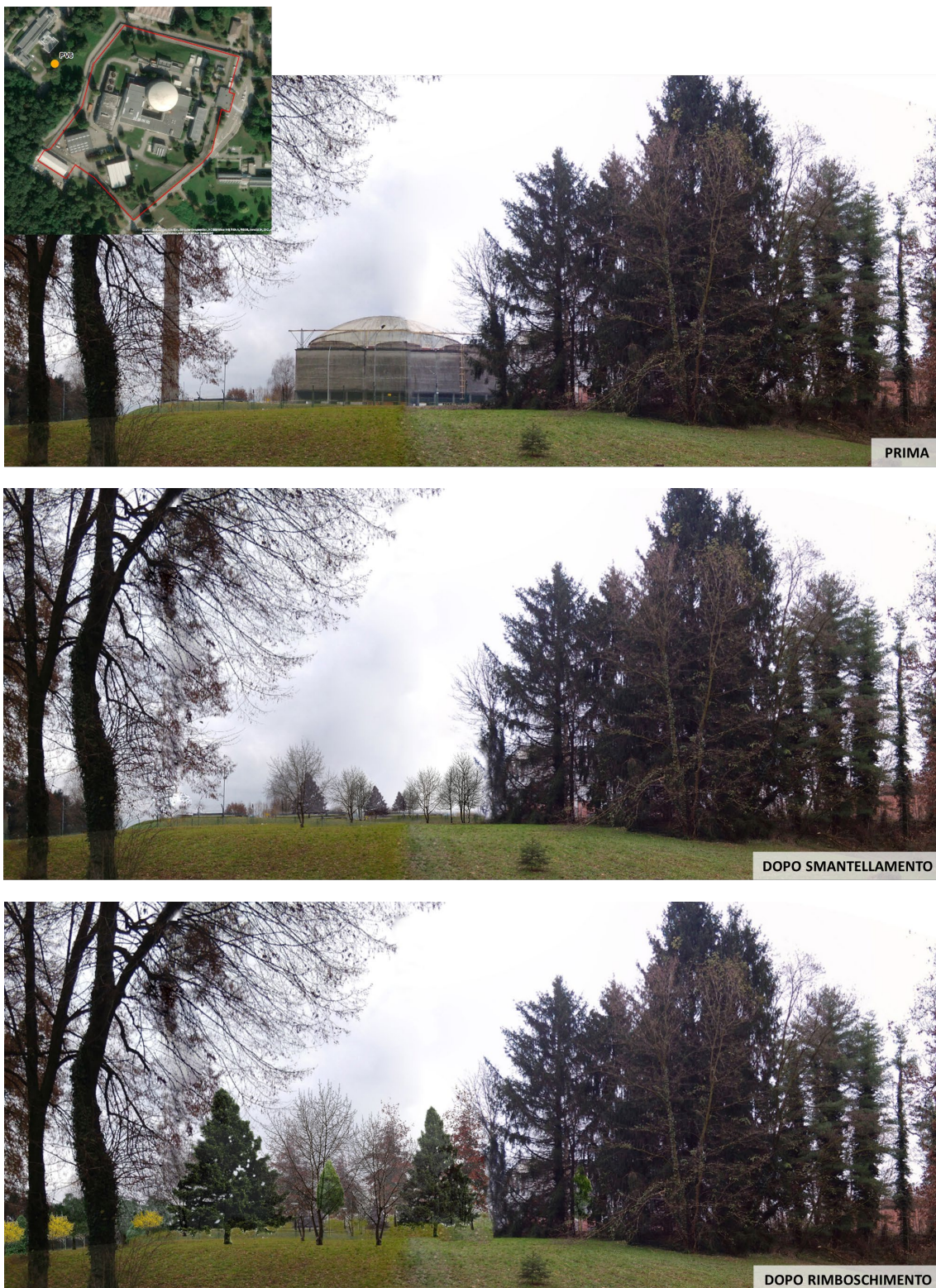
Figura 4-13. PV6 – Panoramica Sud Est del Complesso INE dal punto esterno situato a Ovest del sito (prima e dopo lo smantellamento, dopo il rimboscimento)
