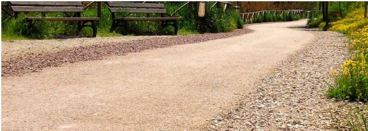
Figura 4-2. Percorso con fondo in terra stabilizzata
