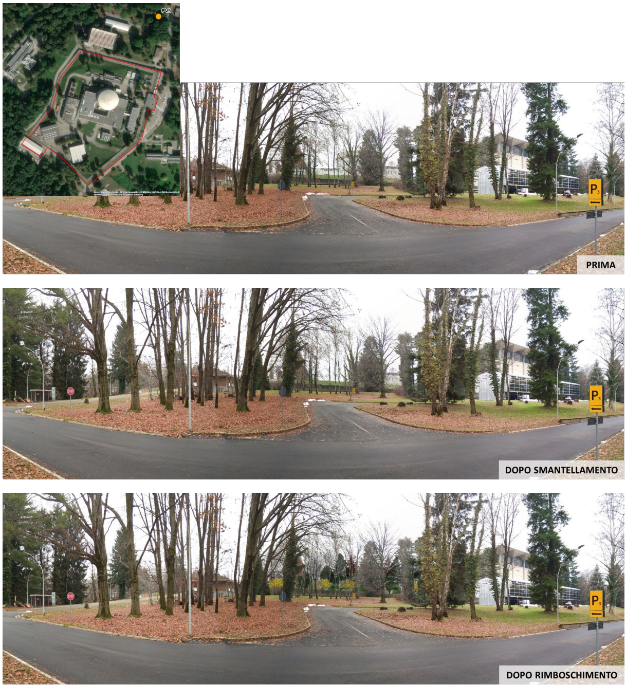
Figura 4-12. PV5 – Panoramica Sud del Complesso INE dal punto esterno situato a Nord del sito (prima e dopo lo smantellamento, dopo il rimboscimento)
