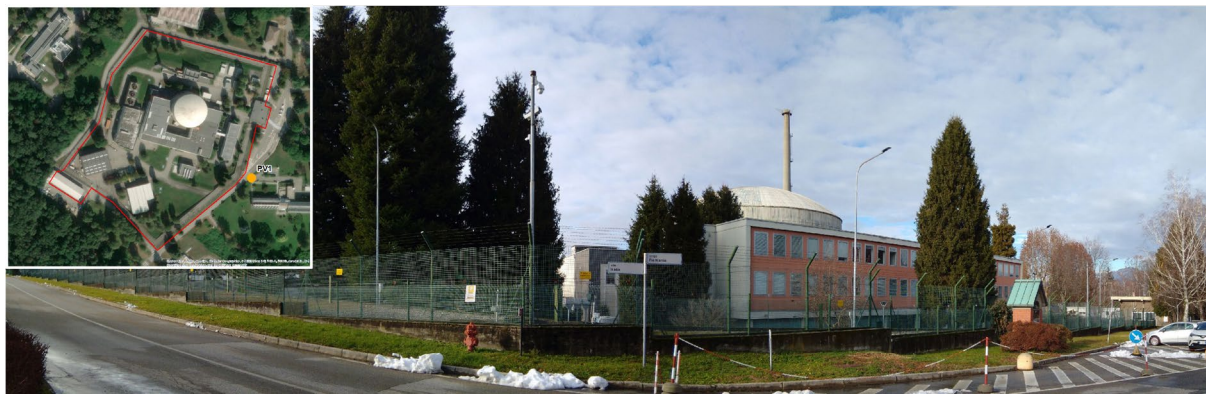
Figura 10-2. Panoramica Nord Ovest del Complesso INE dal punto esterno situato ad Est del sito prima delle attività di progetto
