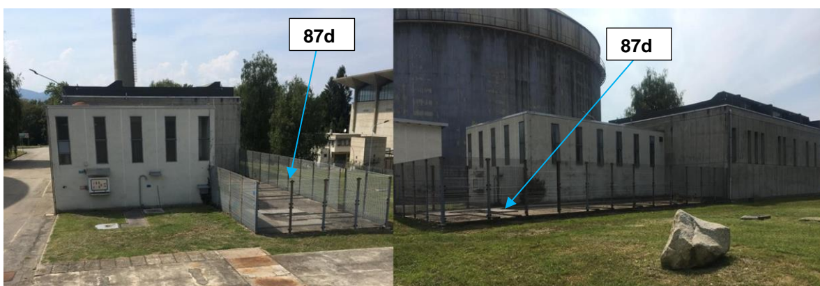
Figura 2-1: Deposito Lubrificanti - 87d
