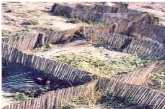
4. Posa in opera di biostuoie in fibra di cocco biodegradabile fissate al suolo con paletti di castagno, atte a stabilizzare le piantagioni e agevolare il trattenimento in situ del substrato sabbioso
