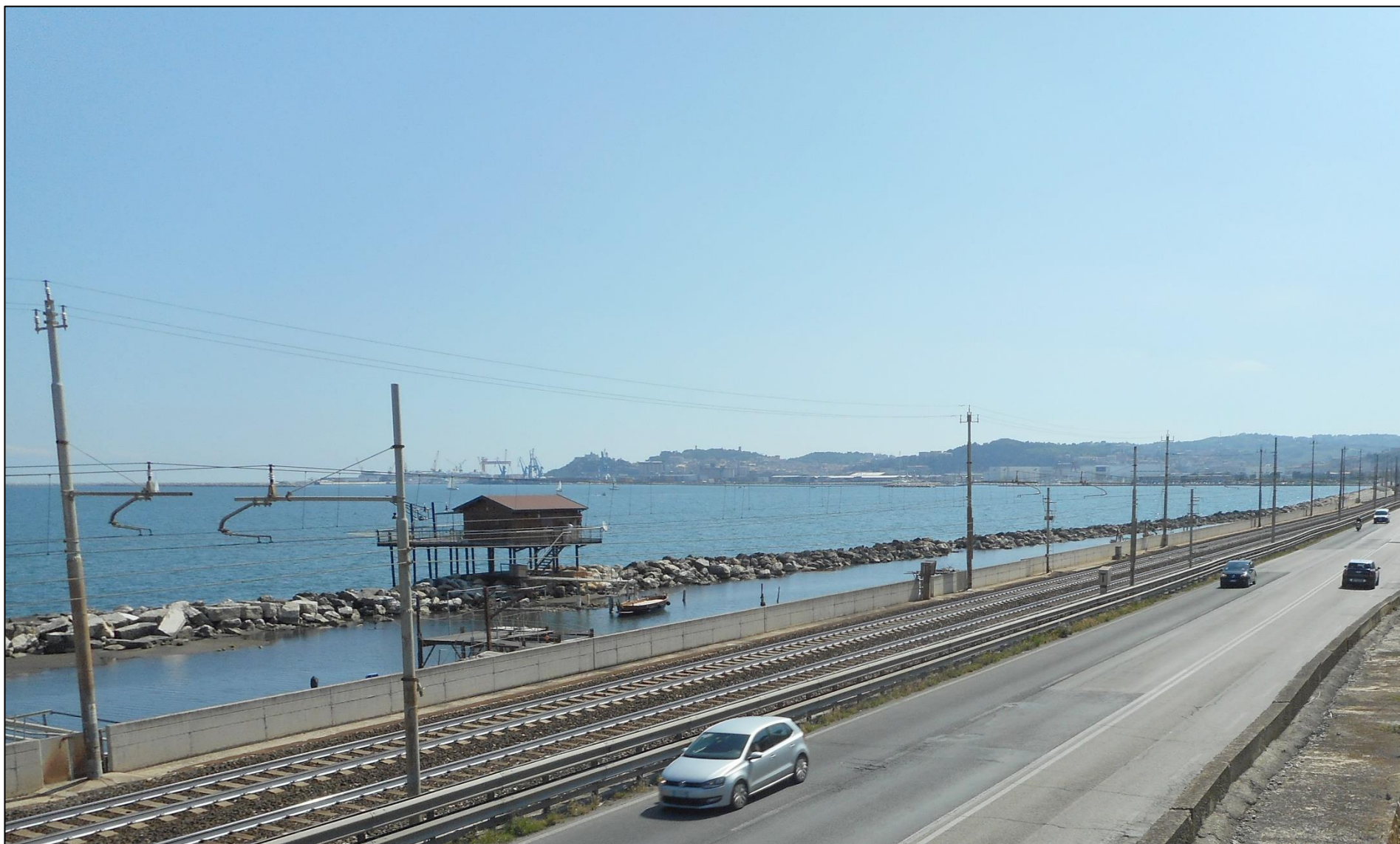
Figura 3 – Punto di vista 2 - percorrendo via Flaminia verso Ancona. Situazione ante operam.
