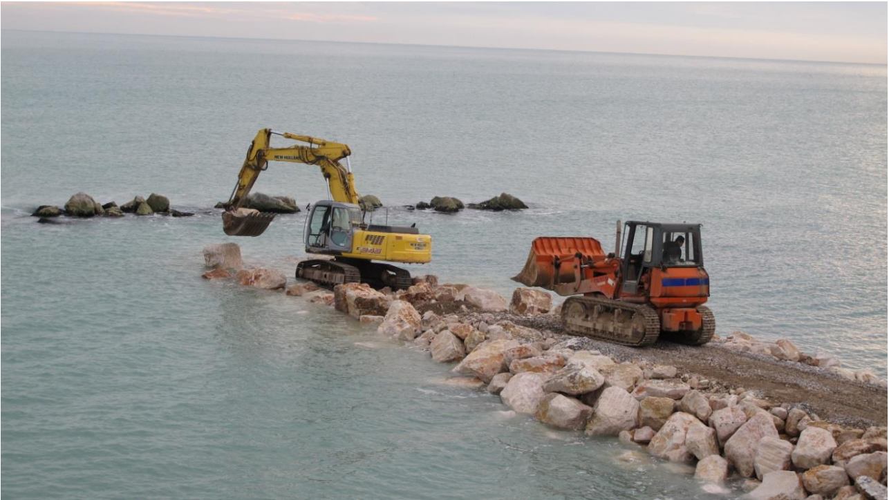
Figura 5 Realizzazione del pennello con escavatore e pala meccanica
