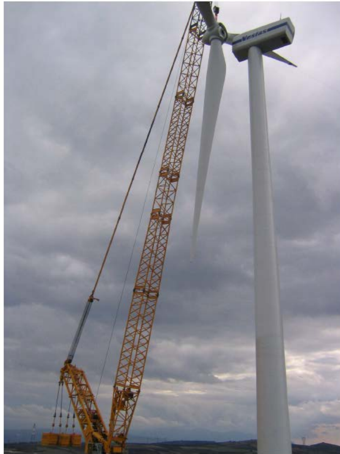
Figura 4 : Fase di montaggio dell'aerogeneratore
