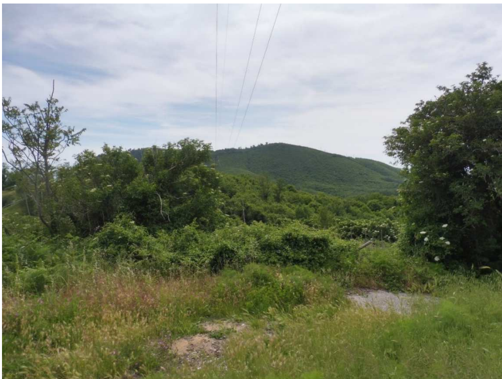
Figura 10: Pista di accesso al sostegno VAL11. Nella prima foto si vede la strada asfaltata esistente e sullo sfondo il sostegno che andrà demolito. Nella seconda foto è evidente l'accesso al prato dalla strada, che in parte risulta già asfaltato
