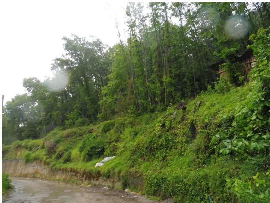
Figura 12: Pista di accesso al sostegno SV03 da adeguare, posizionata nel bosco
