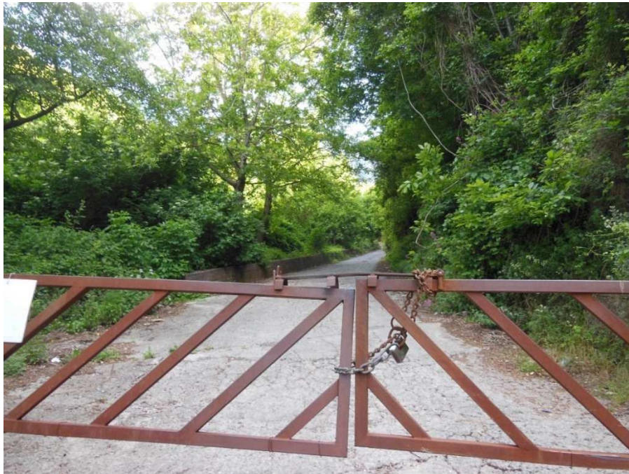
Figura 11: Pista di accesso al sostegno VAL21
