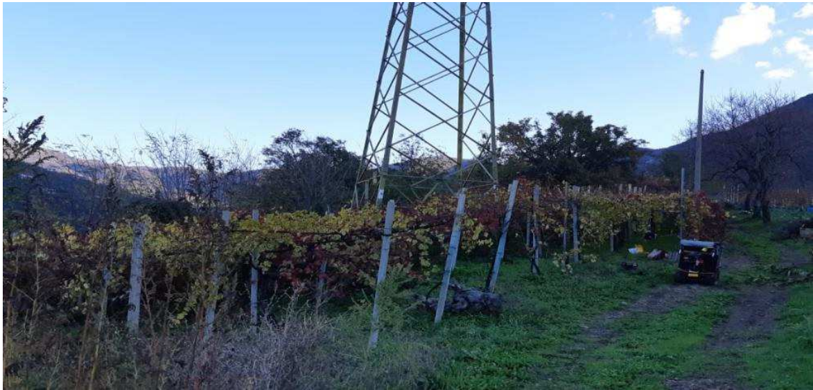
Figura 9: Pista di accesso al sostegno FIN03 (in comune di Castellammare di Stabia) interferente con superfici agricole
