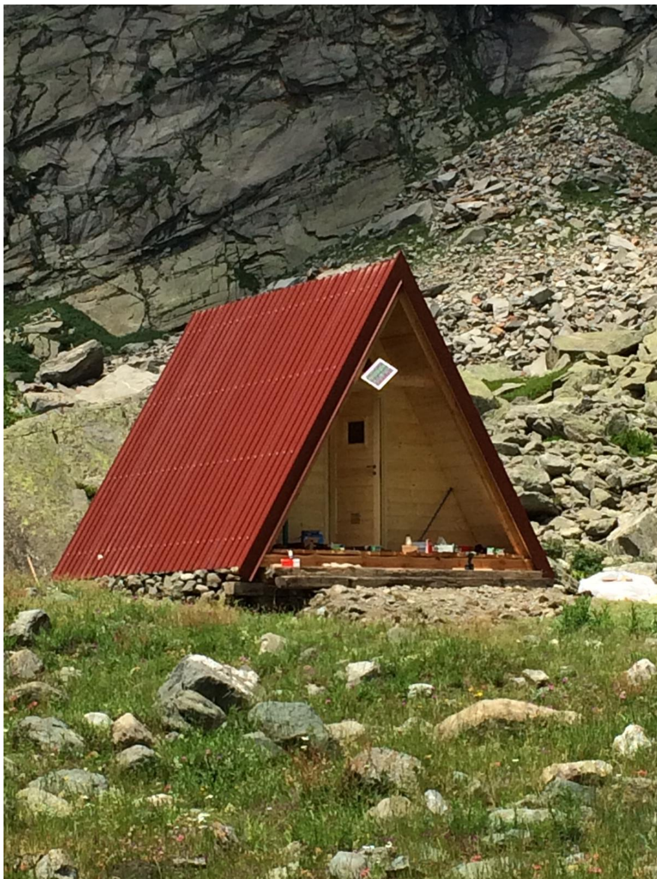
Il bivacco in costruzione
