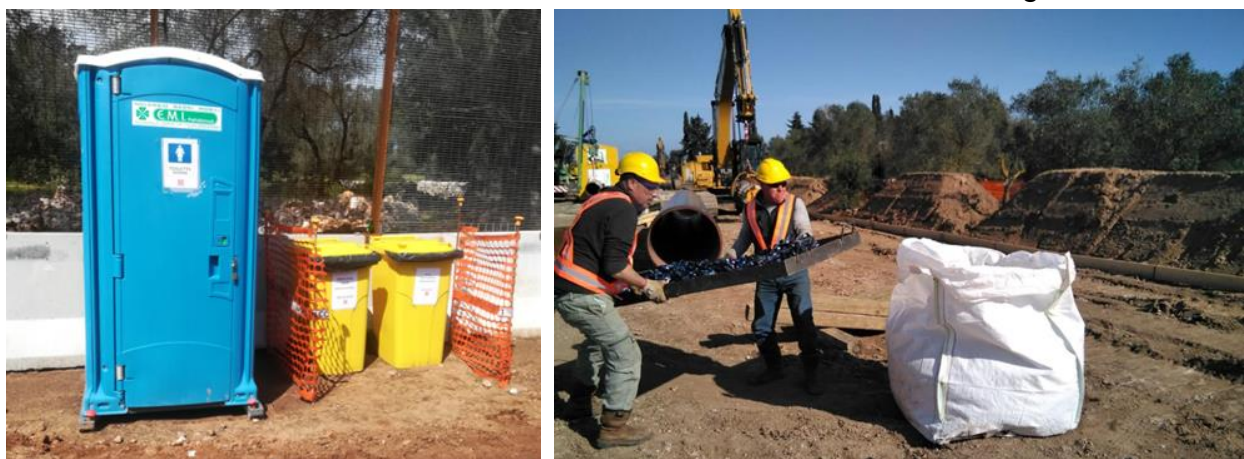
Figura 4: Raccolta rifiuti (sinistra). Confezionamento big bag rifiuto (destra)
