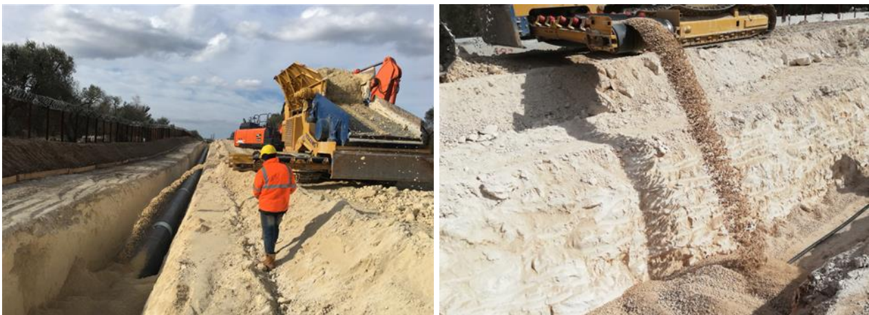
Figura 2 - Operazioni di rinfiacco con Vibrovaglio (sinistra). Operazioni di rinterro con Vibrovaglio (destra)
