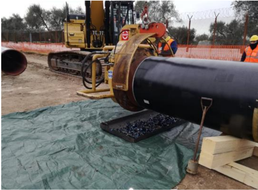
Figura 3: Utilizzo asta magnetica per recupero trucioli ferrosi eventualmente ricaduti sul terreno
