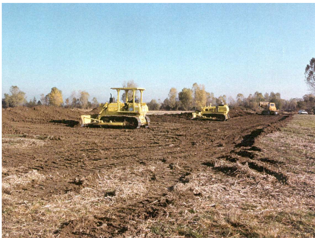
Foto 3.C: Esempio di apertura dell'area di passaggio
