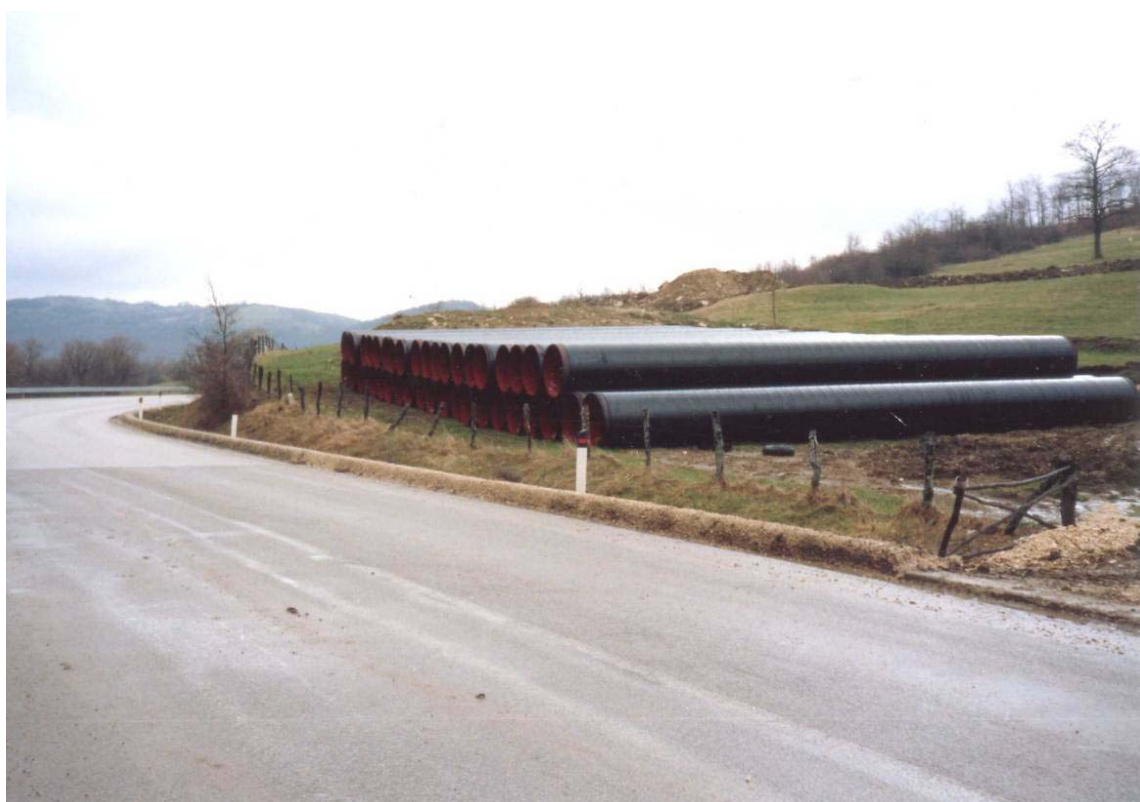
Foto 3.B: Esempio di piazzola di accatastamento tubazioni
