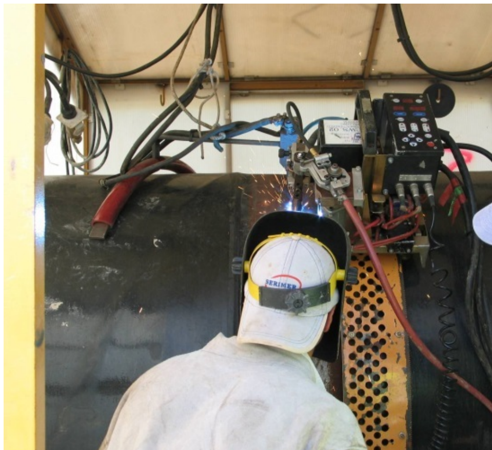
Foto 3.E: Esempio di saldatura di linea
