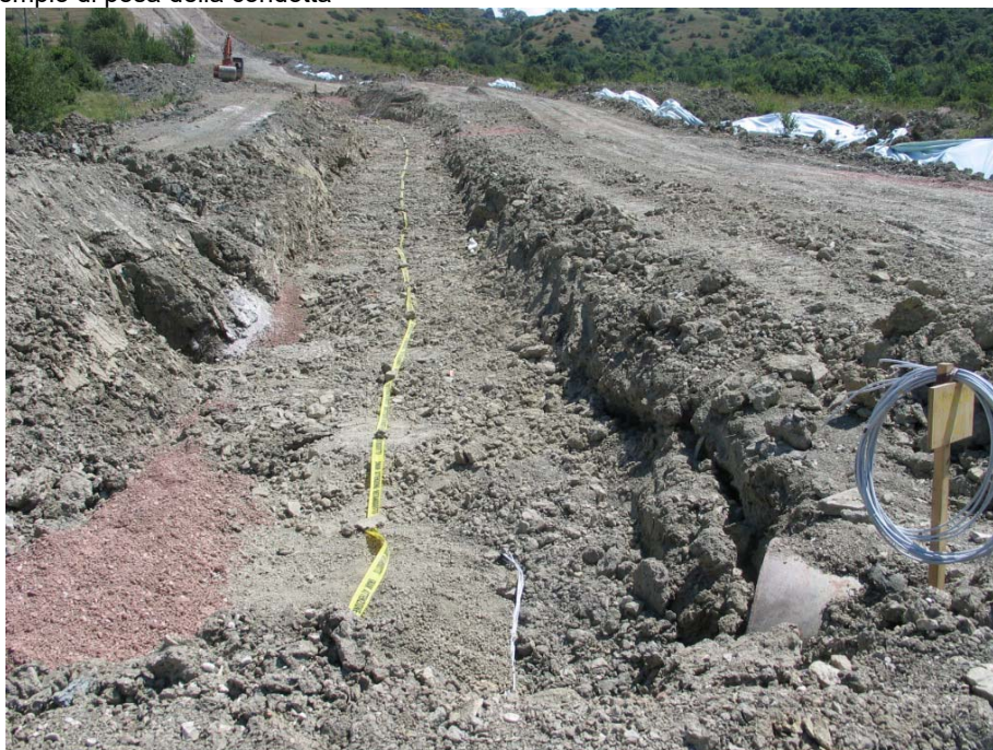
Foto 3.H: Esempio di rinterro della condotta.
