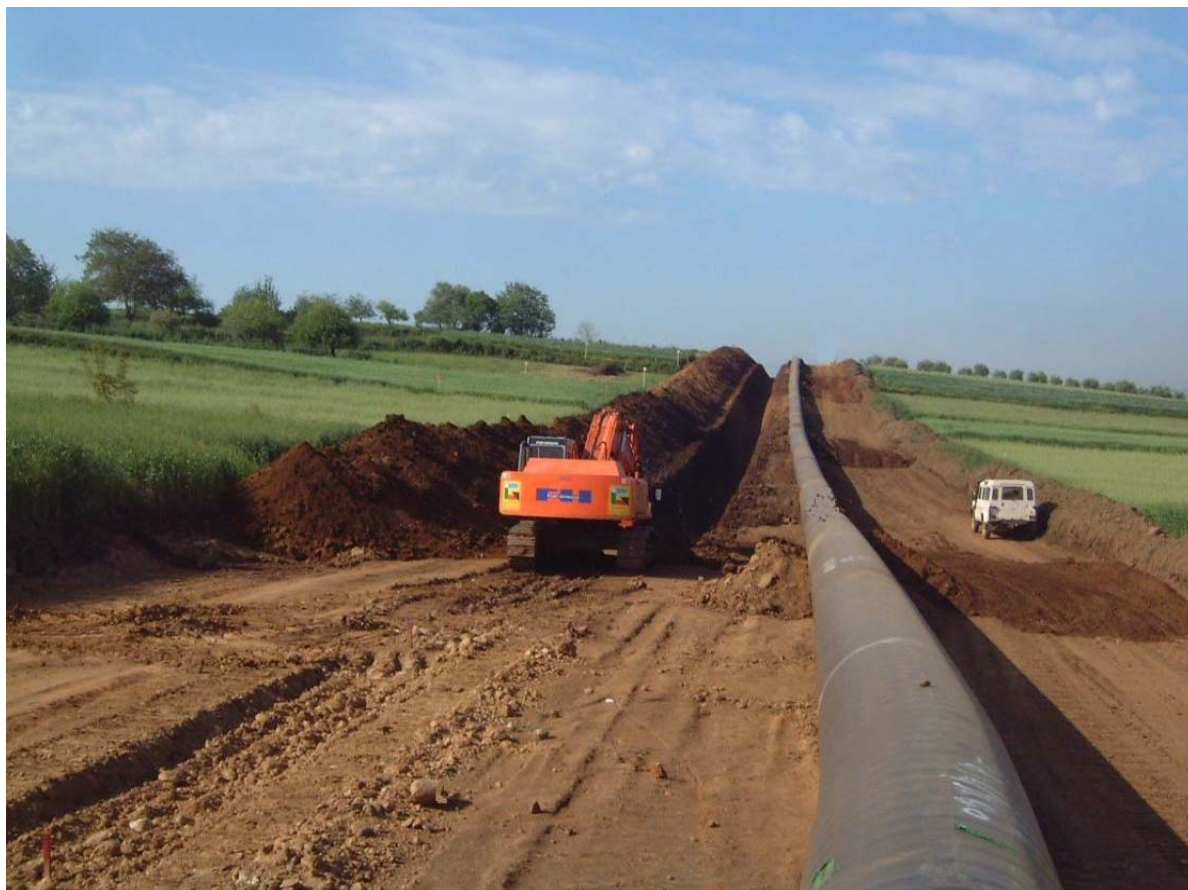
Foto 3.F: Esempio di scavo in trincea
