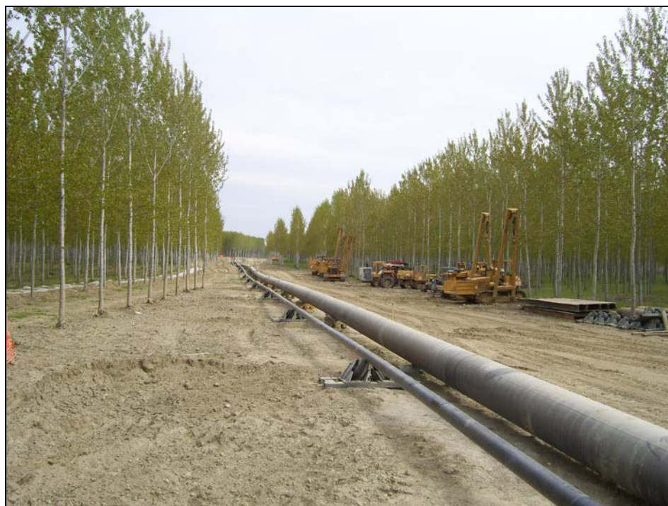
Attrav. F. Po con met. 30" – Colonna della pipeline preassemblata sulla pista di varo
