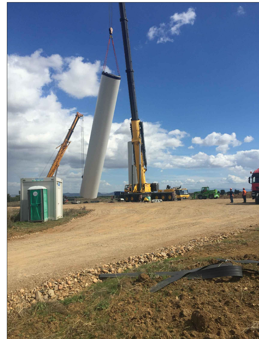
ASSEMBLAGGIO TURBINA
