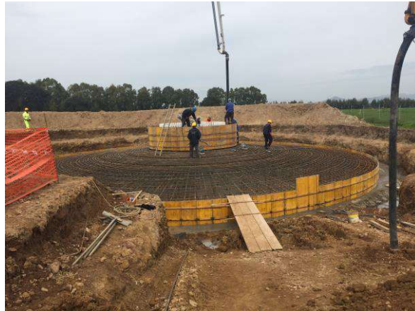
Fig. 19 : armatura di fondazione Parco del Medio Campidano
