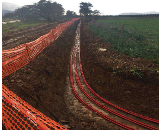
Fig. 22 : posa cavidotti parco del Medio Campidano
