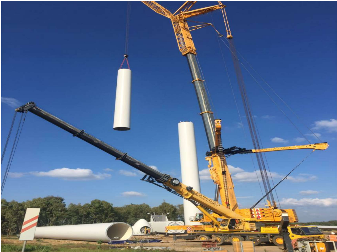
Fig. 14 : montaggio tronco di torre intermedio
