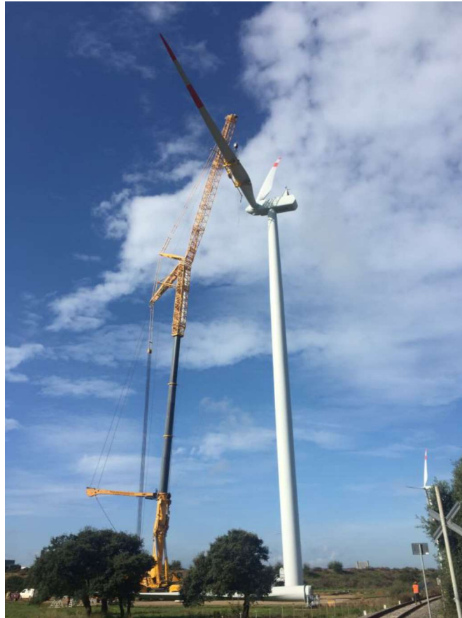
Fig. 16 : montaggio pale
