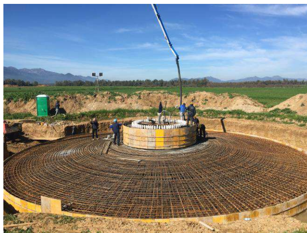
Fig. 20 : getto plinto parco del Medio Campidano
