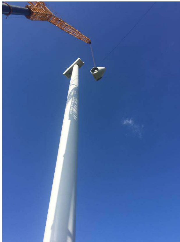
Fig. 15 : montaggio supporto rotore (hub)
