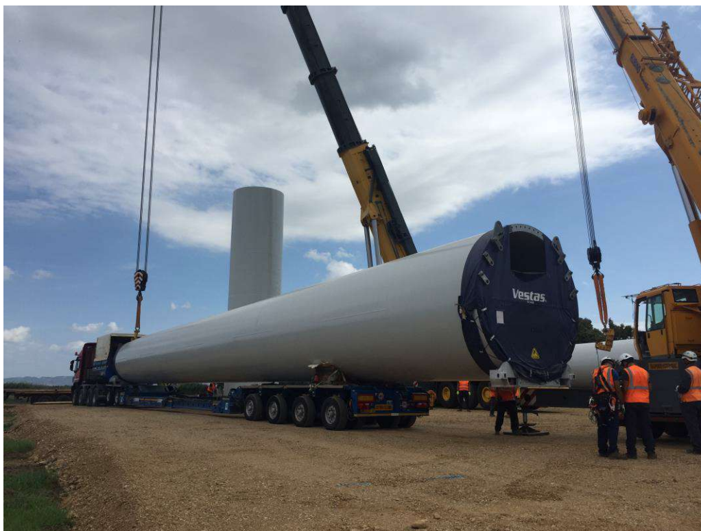
Fig. 11 : scarico di tronco di torre
