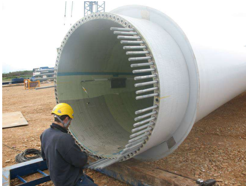
Fig. 6 : vista perni ancoraggio pala
