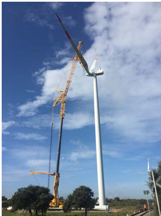
Fig. 16 : montaggio pale
