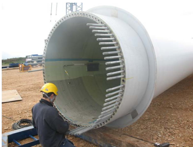
Fig. 6 : vista perni ancoraggio pala
