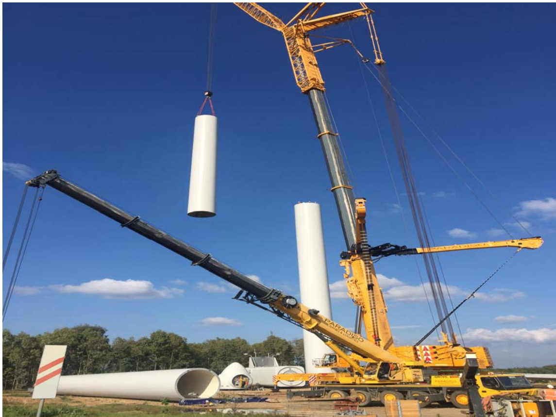
Fig. 14 : montaggio tronco di torre intermedio
