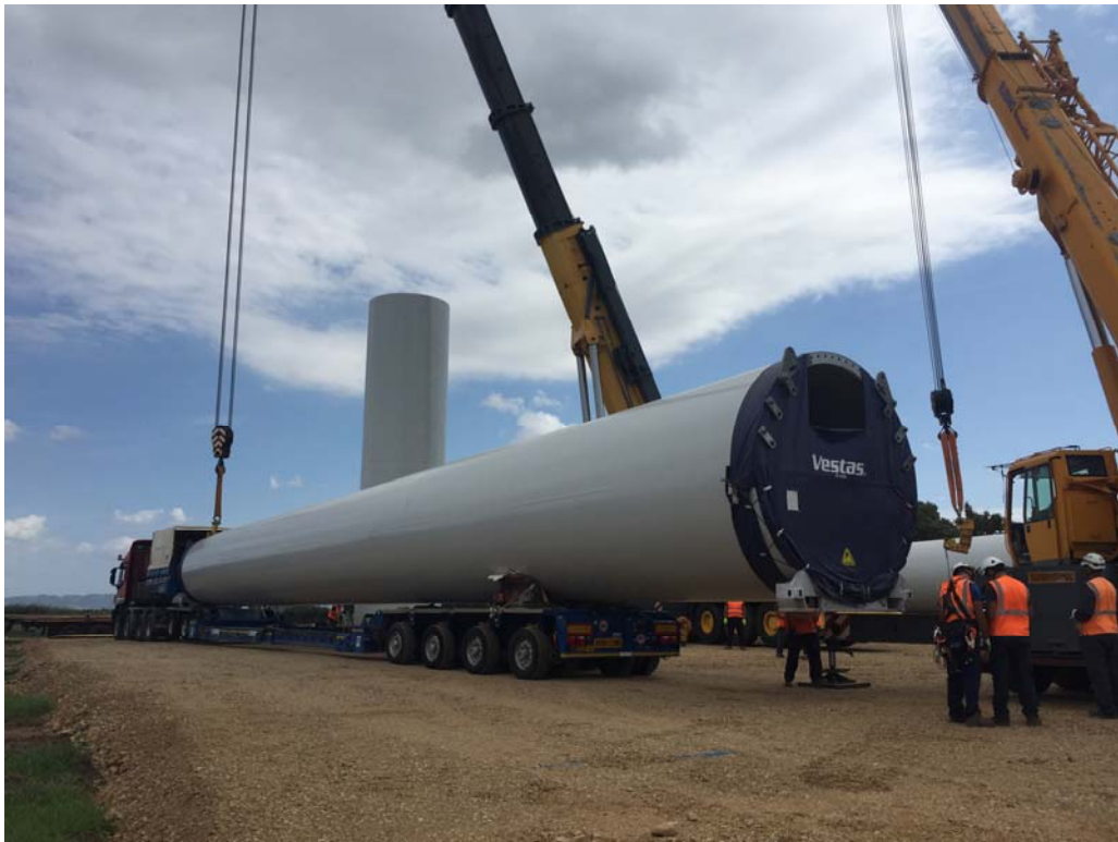
Fig. 11 : scarico di tronco di torre
