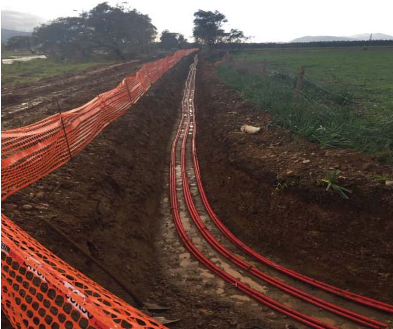
Fig. 22 : posa cavidotti MT parco del Guspinese
