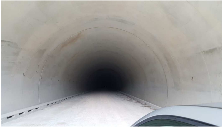
Foto 2 - Interno della Galleria della Guinza
