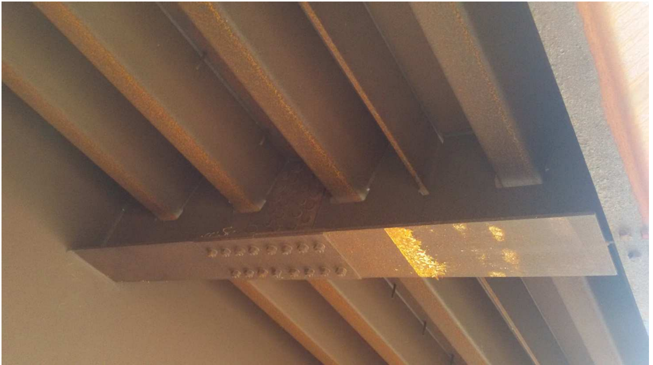
Figura 27 - cordolo del viadotto metallico
