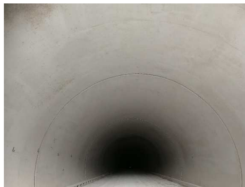
Figura 13 – Rivestimento definitivo galleria Guinza
