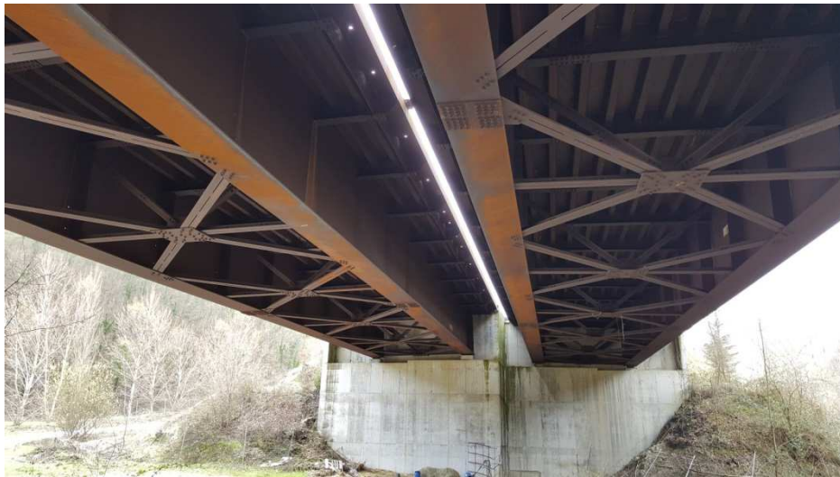
Figura 29 - vista dal basso del viadotto La Pieruccia
