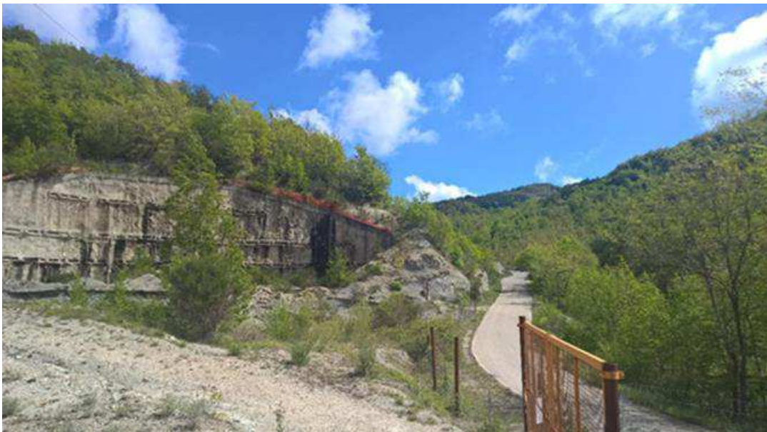
Figura 5 - Viabilità esistente S.P. 200 in prossimità dell'imbocco
