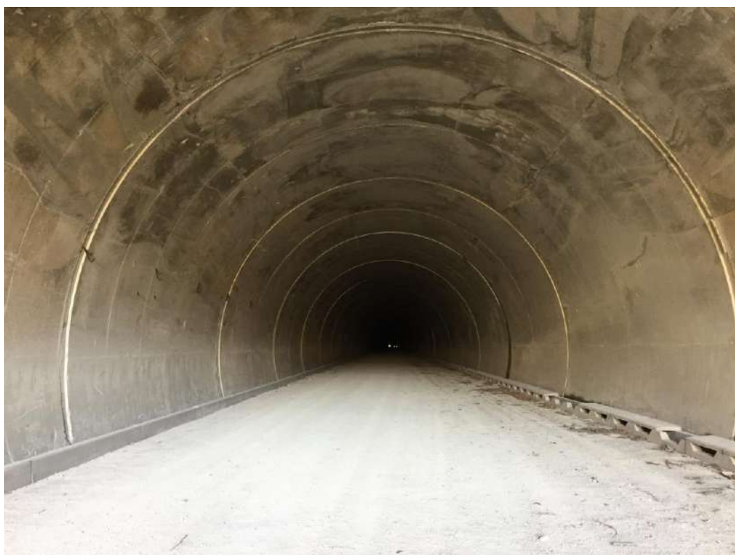
Figura 5 – Interno della Galleria Guinza – E78.
