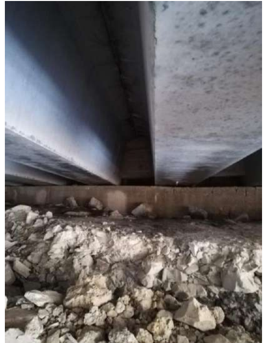
Figura 7-8 – Travetto deteriorato e Dettaglio appoggio travi.
