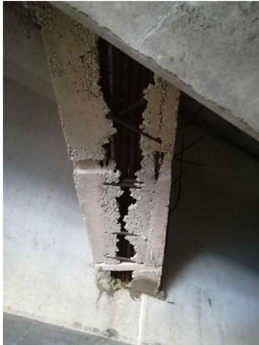
Figura 7-8 – Travetto deteriorato e Dettaglio appoggio travi.
