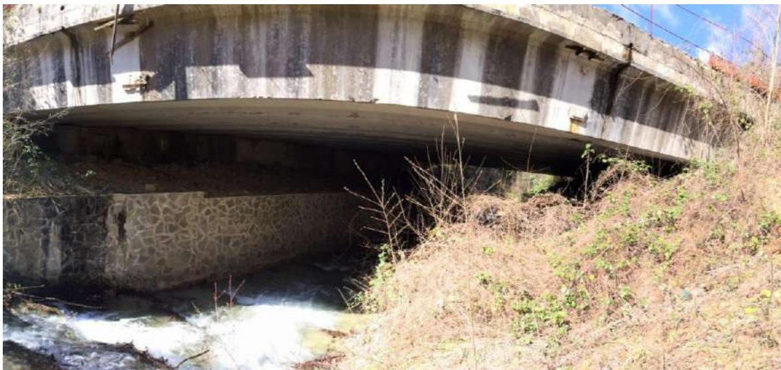
Figura 2 –.Rilievo prospetto est dell'impalcato.
