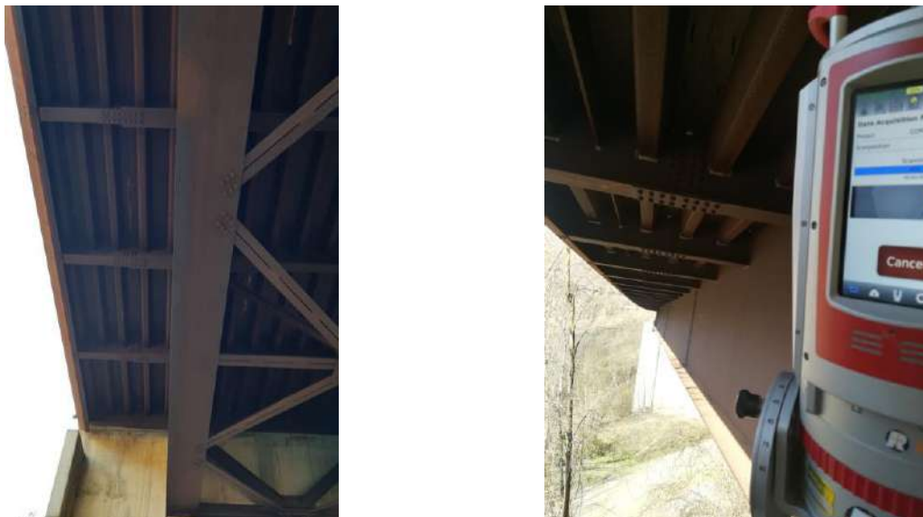
Figura 2 – Rilievo soletta laterale a sbalzo del viadotto - RIEGL VZ-400i.
