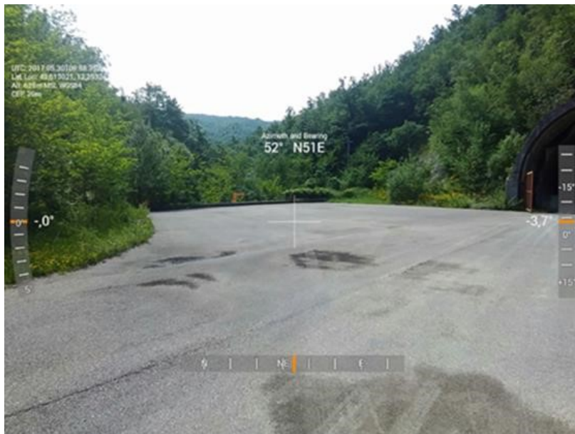
Foto 11 – Area di imbocco galleria Guinza lato Marche
