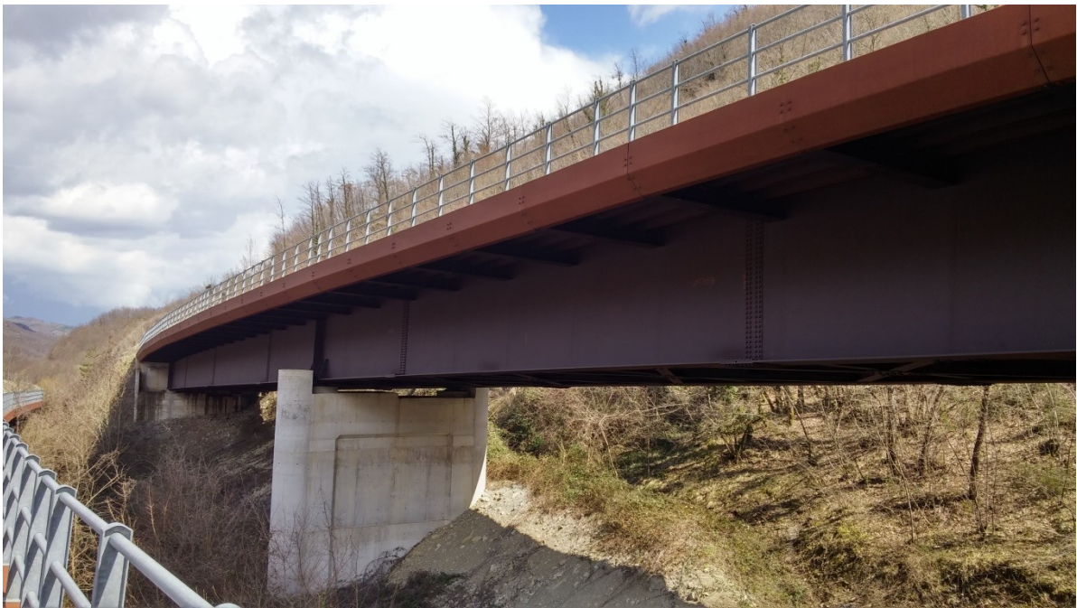
Figura 18 - impalcati sfalsati costituenti il Viadotto Sorgente
