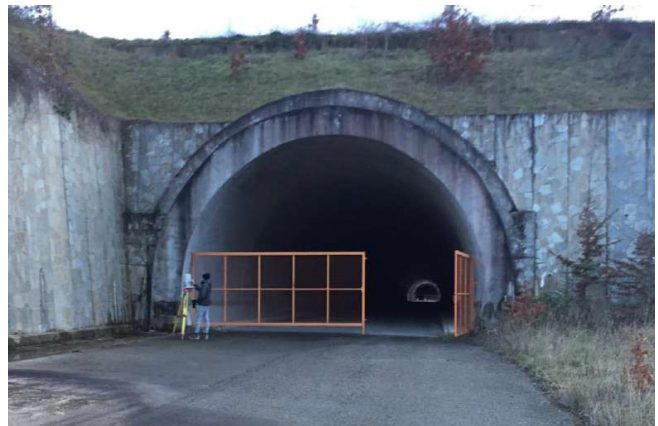
Foto 18 – Galleria Valpiana - imbocco nord lato Marche
