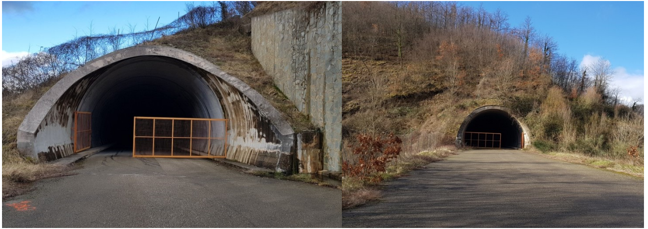
Foto 26 – Galleria S. Antonio - canna nord (tratto lungo) imbocco sud lato Umbria
