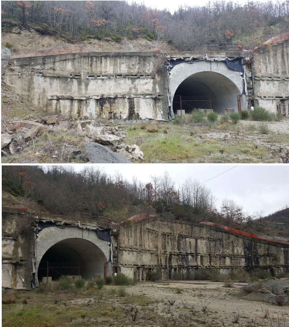
Figura 30 - paratia tipo berlinese all'imbocco sud della galleria Guinza
