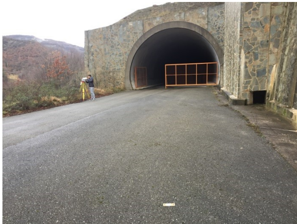
Foto 24 – Galleria S. Antonio - canna sud (tratto corto) imbocco sud lato Umbria
