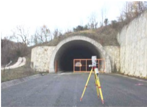
Foto 17 – Galleria Valpiana - imbocco sud lato Umbria
