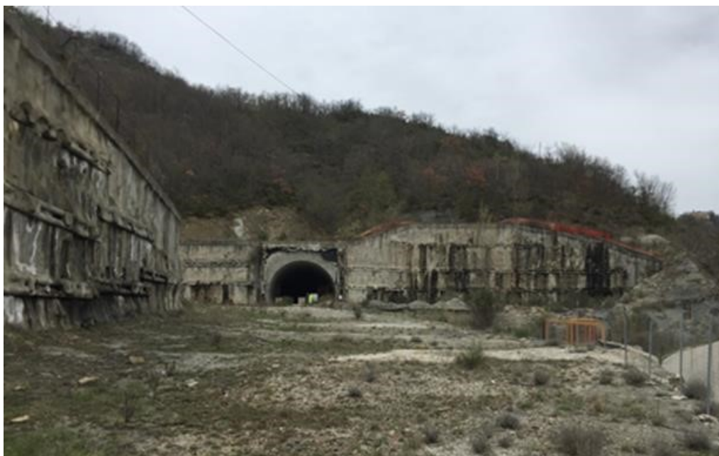
Foto 8 – Area di imbocco Galleria Guinza lato Umbria
