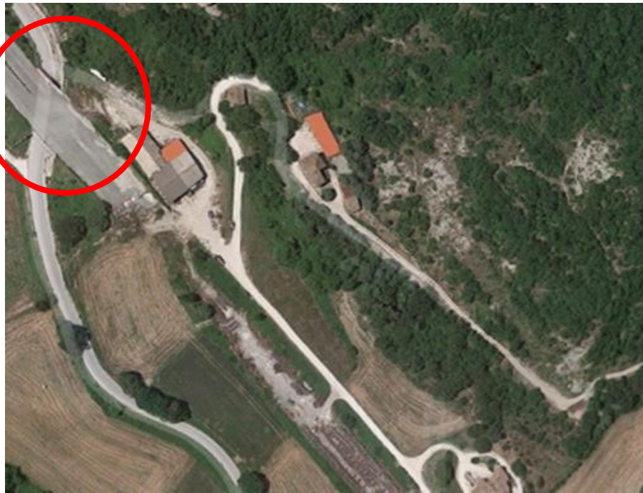
Foto 30 - Sottovia scatolare comunale
