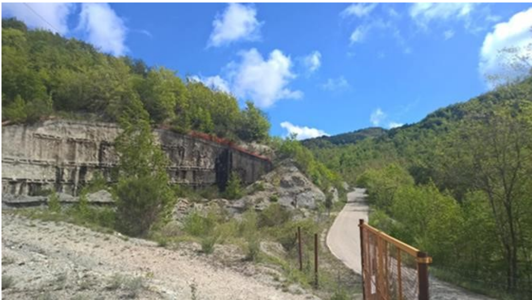
Foto 7 – Viabilità esistente S.P. 200 in prossimità dell'imbocco
