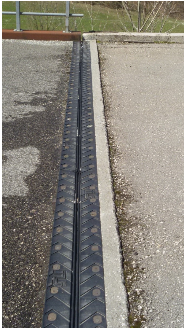
Foto 23 – Dettaglio giunto viadotto sorgente
