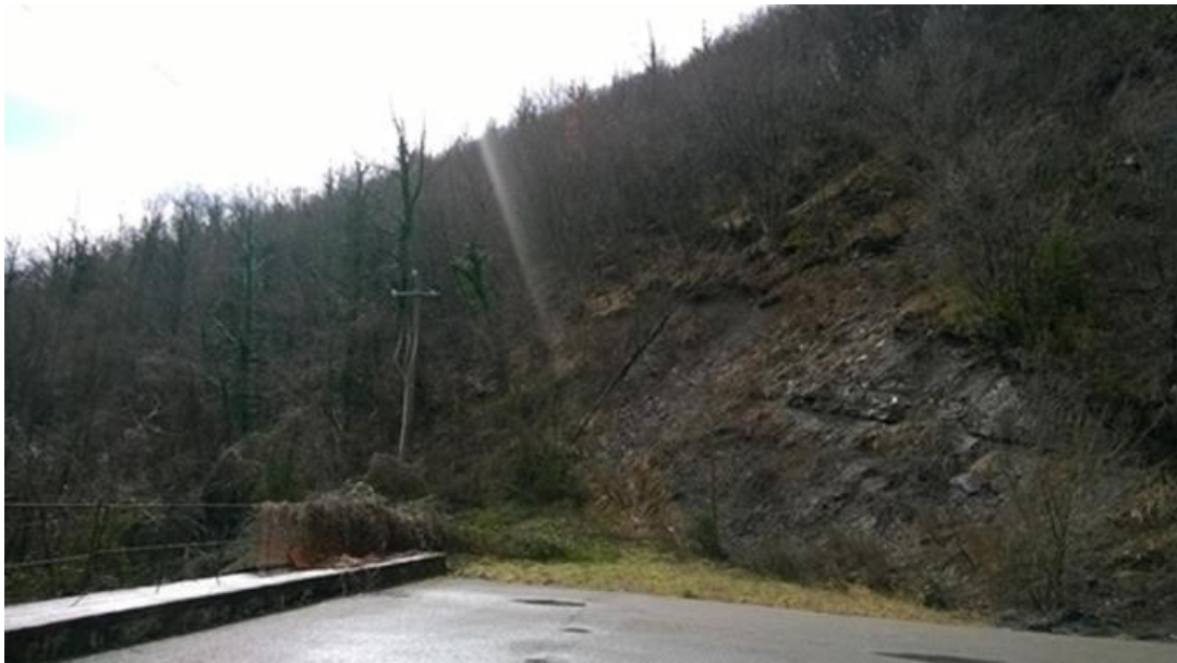
Foto 16 – Ponte- Dettaglio cordolo
