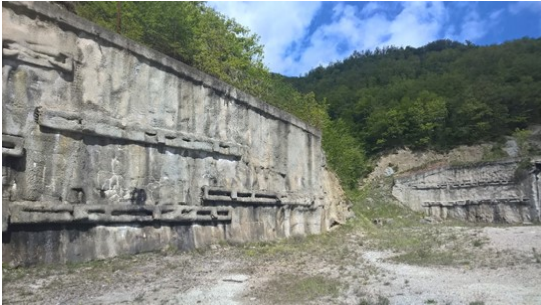
Foto 6 – Paratie laterali ubicate nell'area di imbocco
