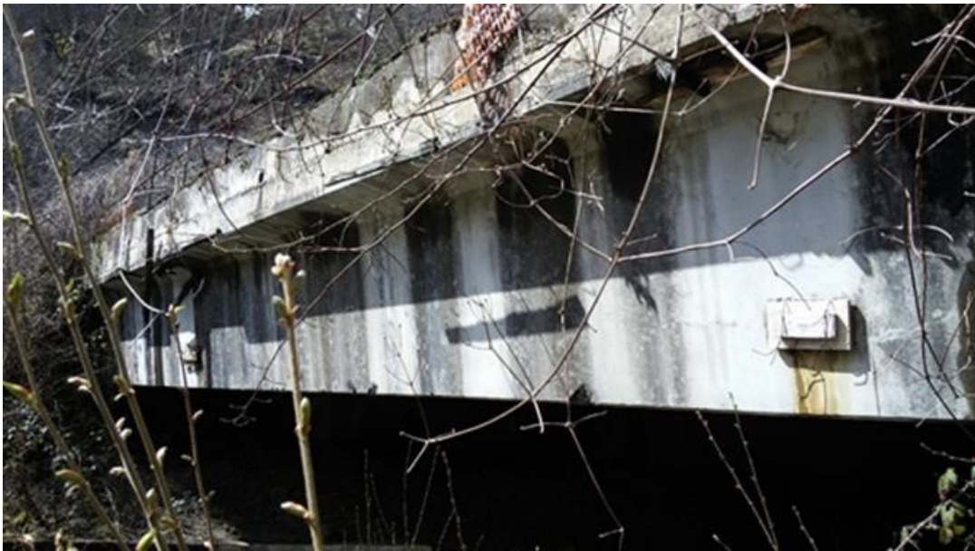
Foto 14 – Ponte – Dettaglio trave di bordo
