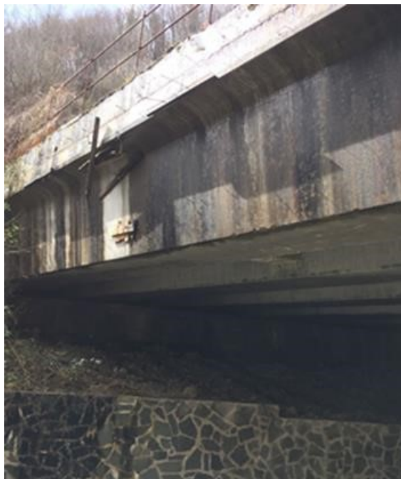
Foto 15 – Ponte – Dettaglio trave di bordo
