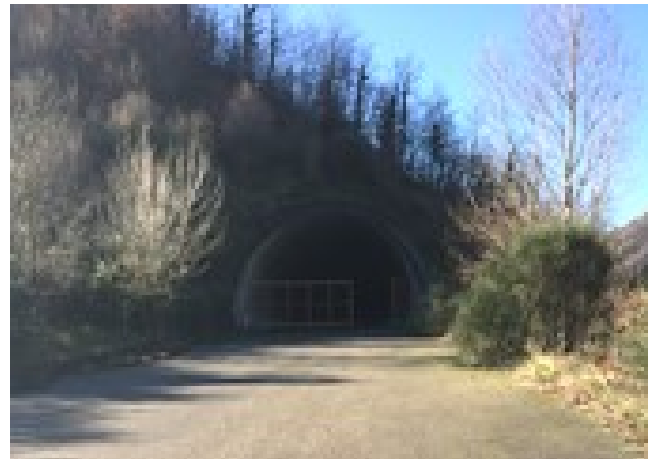
Foto 25 – Galleria S. Antonio - canna sud (tratto corto) imbocco nord lato Marche
