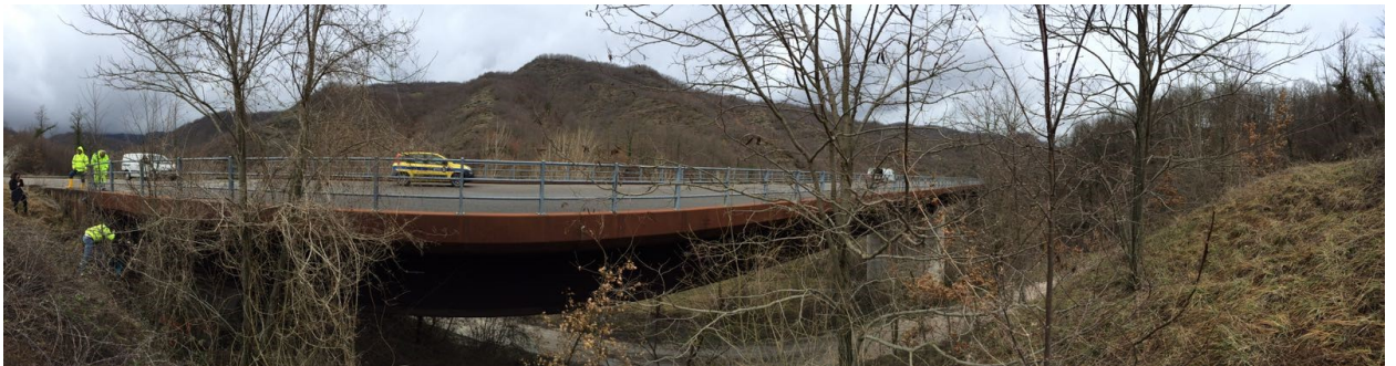
Foto 19 – Vista di insieme
