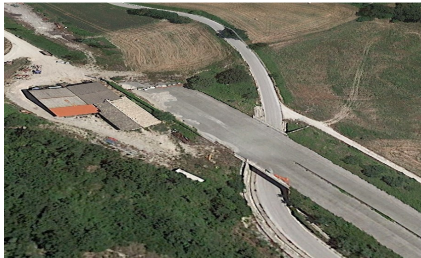
Figura 28 - termine dell'intervento lato Mercatello s. M.
