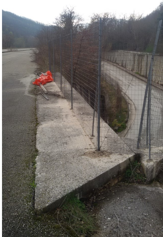
Foto 33 – Particolare cordolo sottovia scatolare
