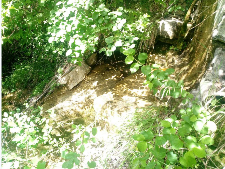
Fig. 44: Uscita dell'attraversamento idraulico sotto la strada provinciale, con flusso limitato ma comunque presente.
