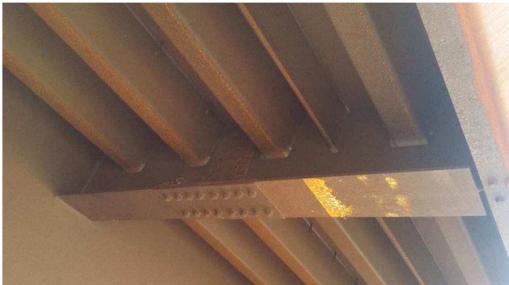
Figura 43 - Cordolo del viadotto metallico
