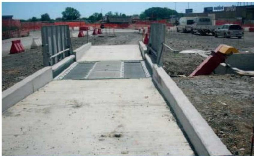
Figura 77 - Esempio di impianto di lavaggio ruote
