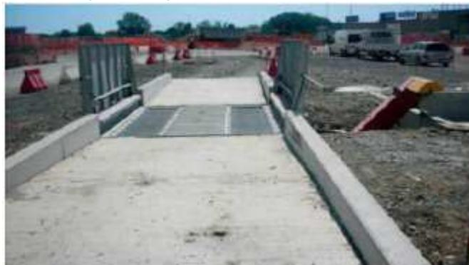
Figura 75 - Impianto di lavaggio pneumatici
