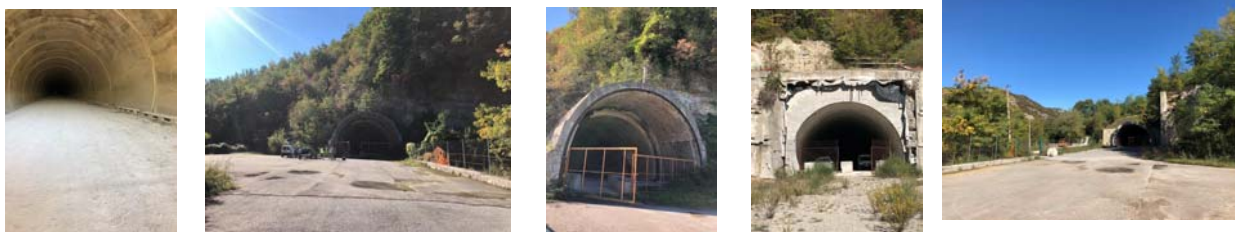
Fig.02 – foto sullo stato di fatto delle aree oggetto di intervento impiantistico
