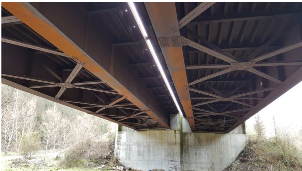
Figura - vista dal basso del viadotto La Pieruccia
