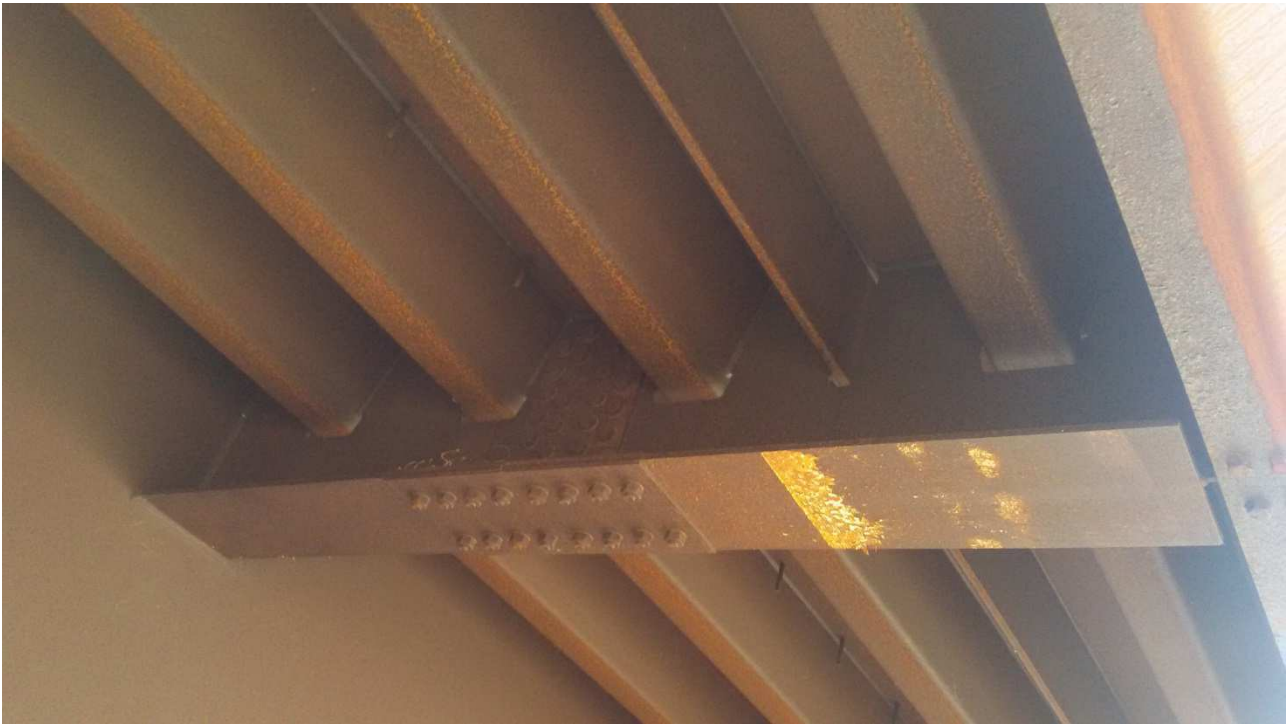
Figura - cordolo del viadotto metallico
