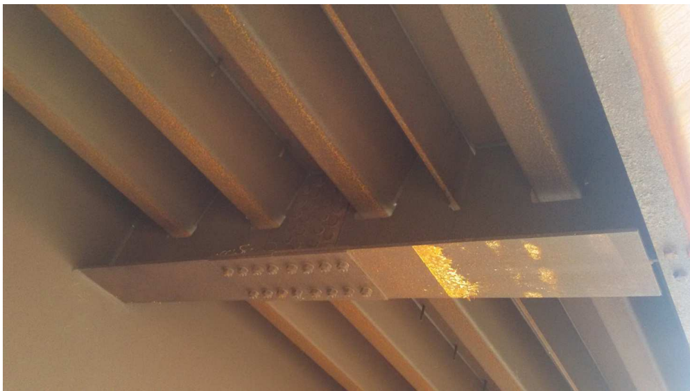
Cordolo del viadotto metallico
