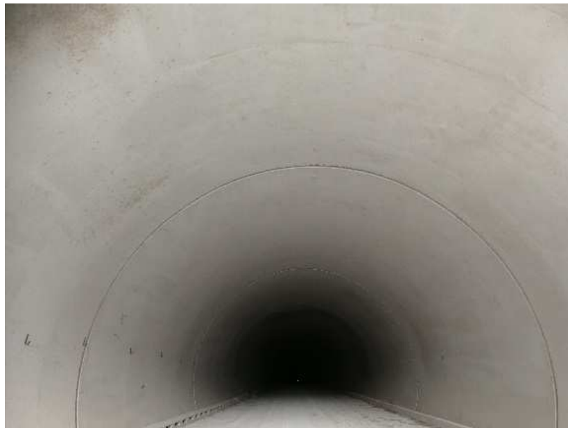
Figura – Rivestimento definitivo galleria Guinza
