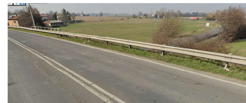
Figura 2-34. Vista del sottopasso Segnatello verso Nord dal tracciato stradale esistente.
