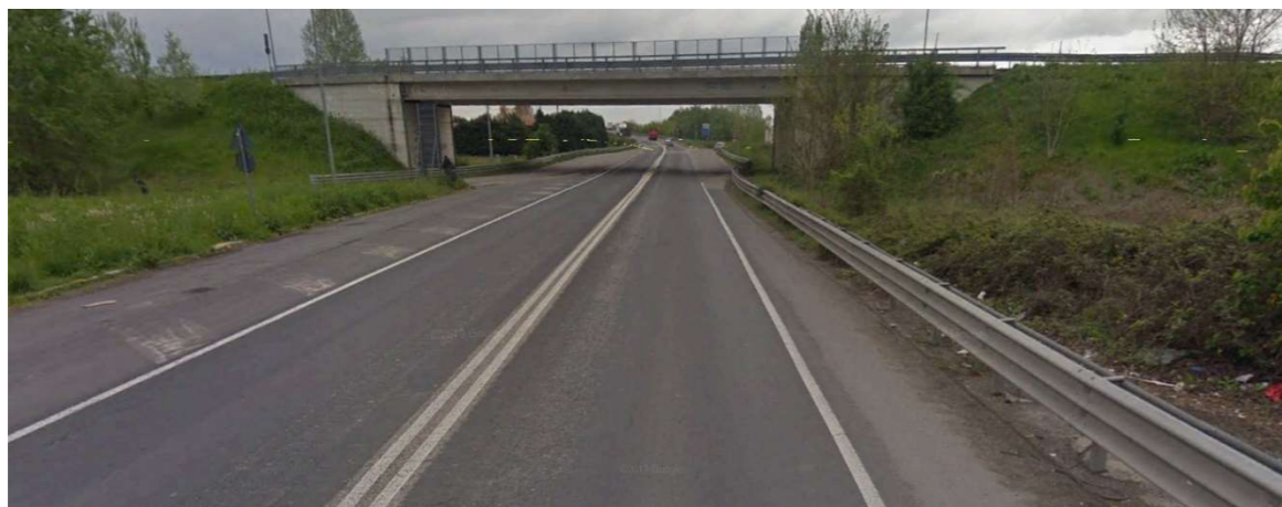
Figura 2-40. Viadotto Via Saliceto e strada in rilevato
