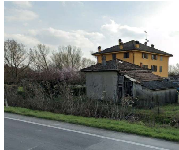
Figura 2-15. "Strutture residenziali isolate" presso torrente Navile
