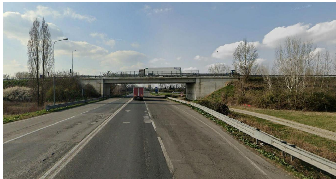
Figura 3-6 Vista fotografica del cavalcavia al km 1+800 – 1+900
