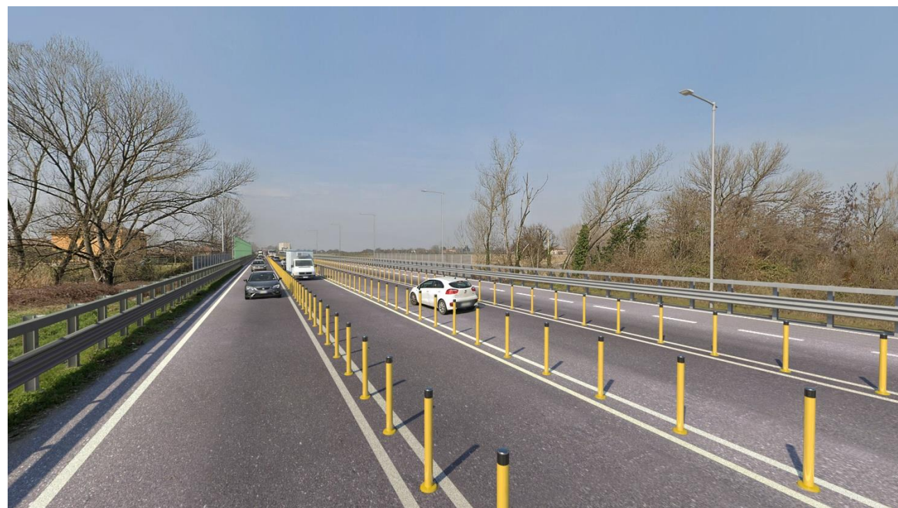
Figura 6-2 Ponte sul canale Navile post mitigazione
