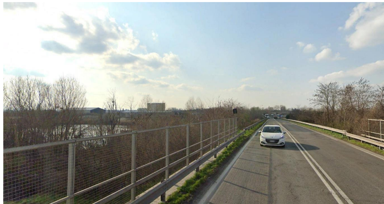
Figura 3-8 Vista fotografica dal viadotto posto al di sopra dell'A13
