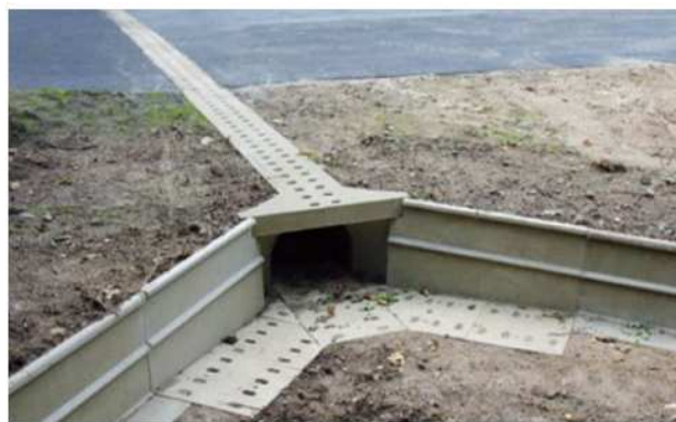
Tipologico manufatto carrabile per consentire l'attraversamento da parte della batracofauna
