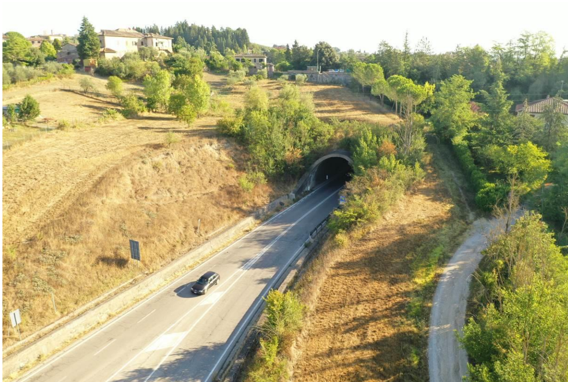
Figura 16 – Orlo di scarpata antropica a ridosso dell'imbocco lato Grosseto della galleria S. Lazzerò, parzialmente in evoluzione (immagine da drone, 2020)
