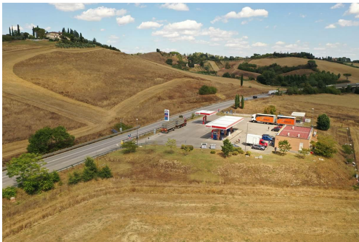
Figura 17 – Orlo di scarpata antropica a monte dell'area di servizio Esso
