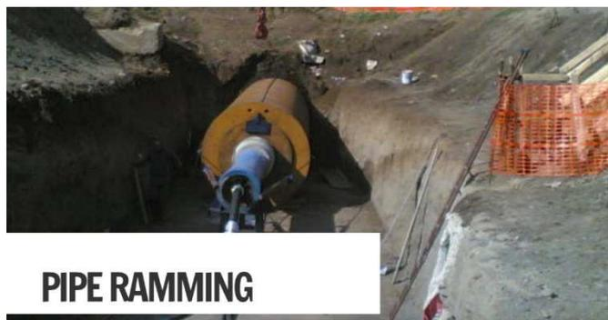
Il sistema "Pipe Ramming" consiste sostanzialmente nell'infilaggio di tubi in acciaio nel terreno, per battitura. Tale sistema è basato sull'impiego di unità percussive (rammer) pneumatiche che vengono utilizzate per batter la testa di spezzoni di tubo in
