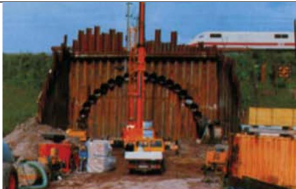
Realizzazione di calotta per sottopasso ferroviario
