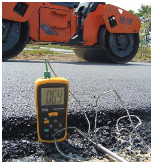
Figura 6: temperatura della miscela durante la compattazione dello strato
