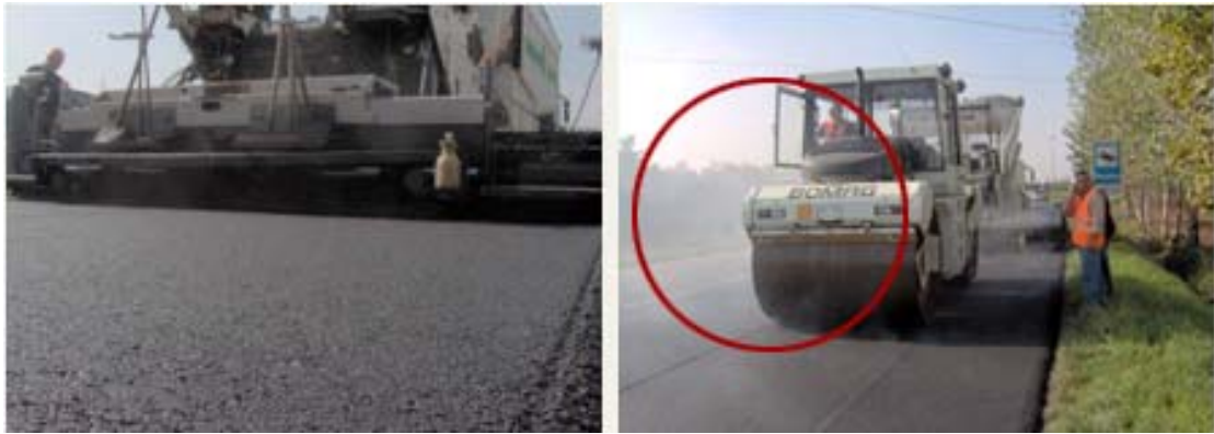
Figura 5: confronto tra conglomerato bituminoso tradizionale e Warm Mix Asphalt in termini di produzione di fumi durante la stesa
