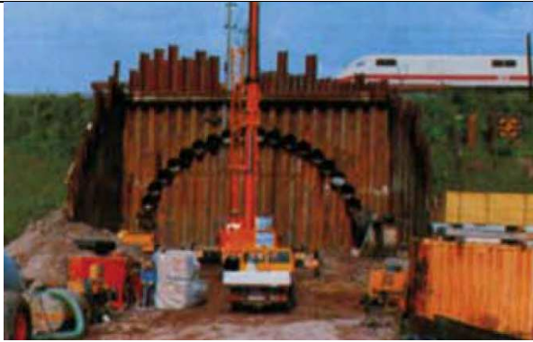
Realizzazione di calotta per sottopasso ferroviario
