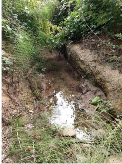
Figura 16 - Fondo limoso-argilloso- sabbioso-Fosso di Valli - Viadotto Valli
