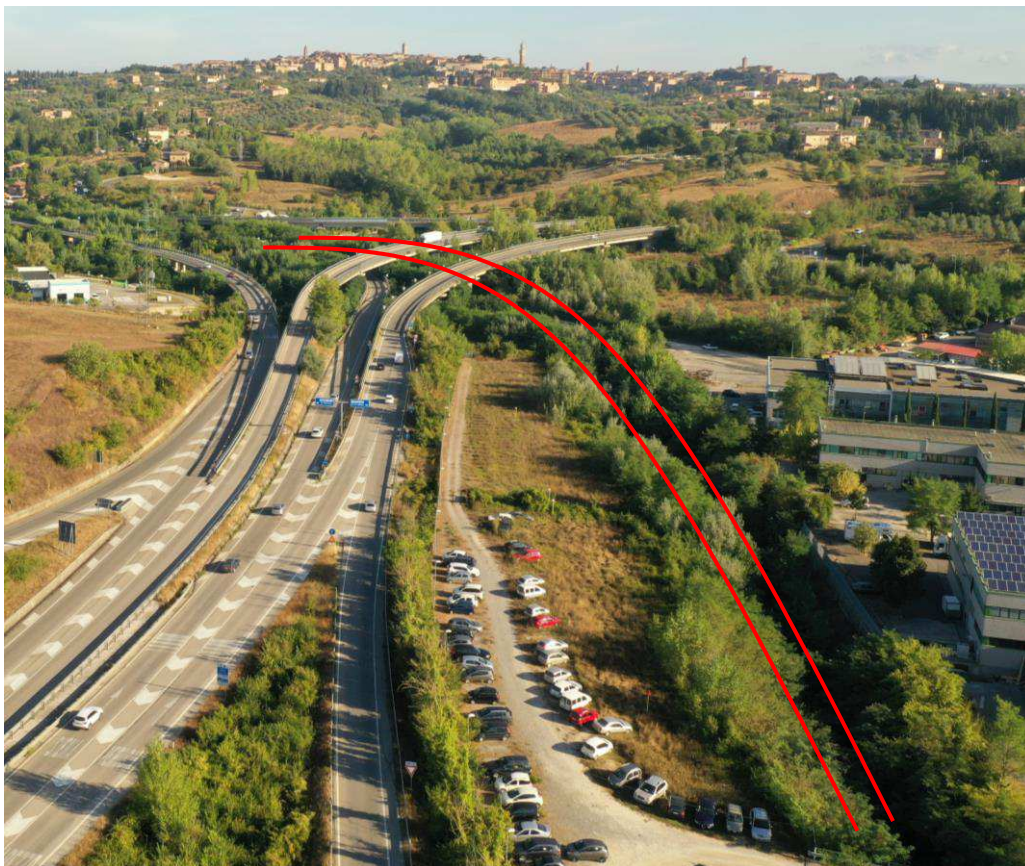
Figura 4 - Vegetazione ripariale esistente torrente Tressa
