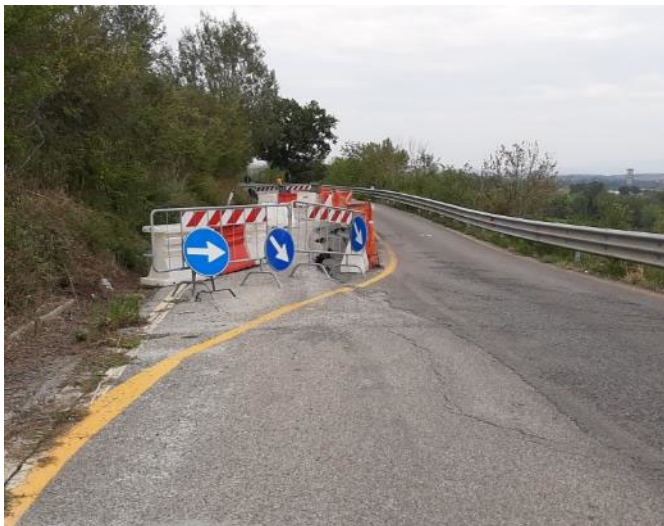
Figura 201 - Movimento franoso rilevato in fase di SL in loc.San Beci sulla SP 136
