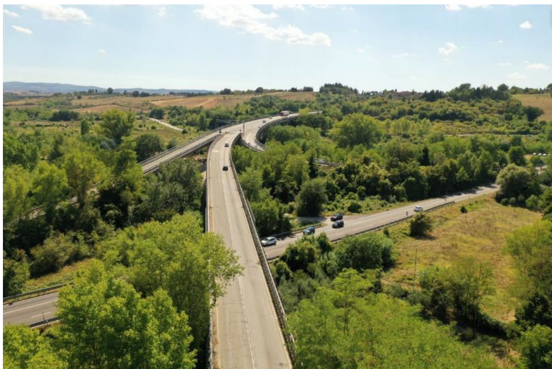
Figura 266 - Svincolo Siena Est. Ripresa aerea, agosto 2020.
