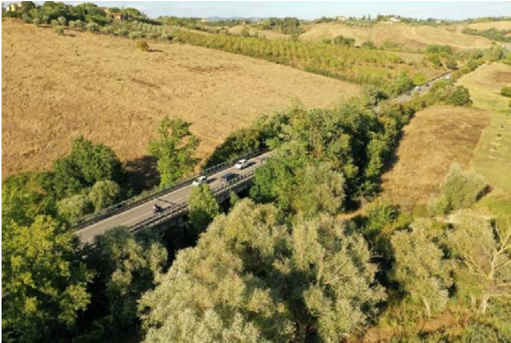
Figura 85 – Vista aerea del viadotto delle Luglie (dir. Fano) con vegetazione ripariale del fosso delle Luglie ( Salix alba , seminativi e oliveti (tappa 2)
