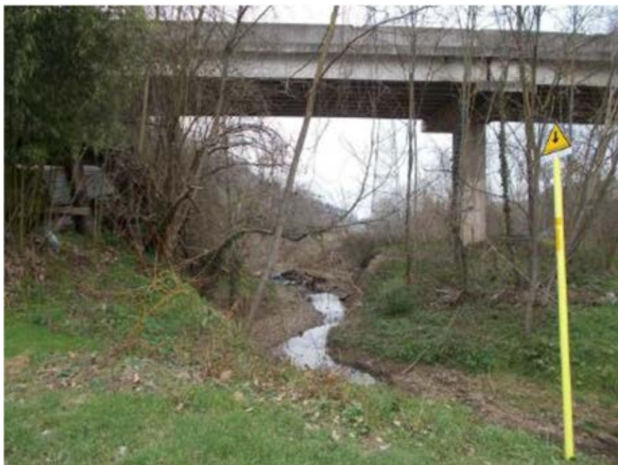
Figura 225 - Sotto attraversamento del Tressa sullo svincolo della tangenziale ovest
