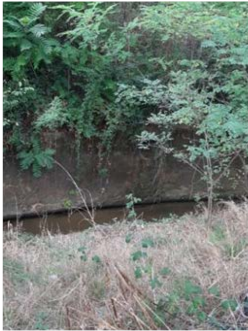
Figura 228 - Tratto artificiale incanalato area parcheggio Caserma VV.FF.
