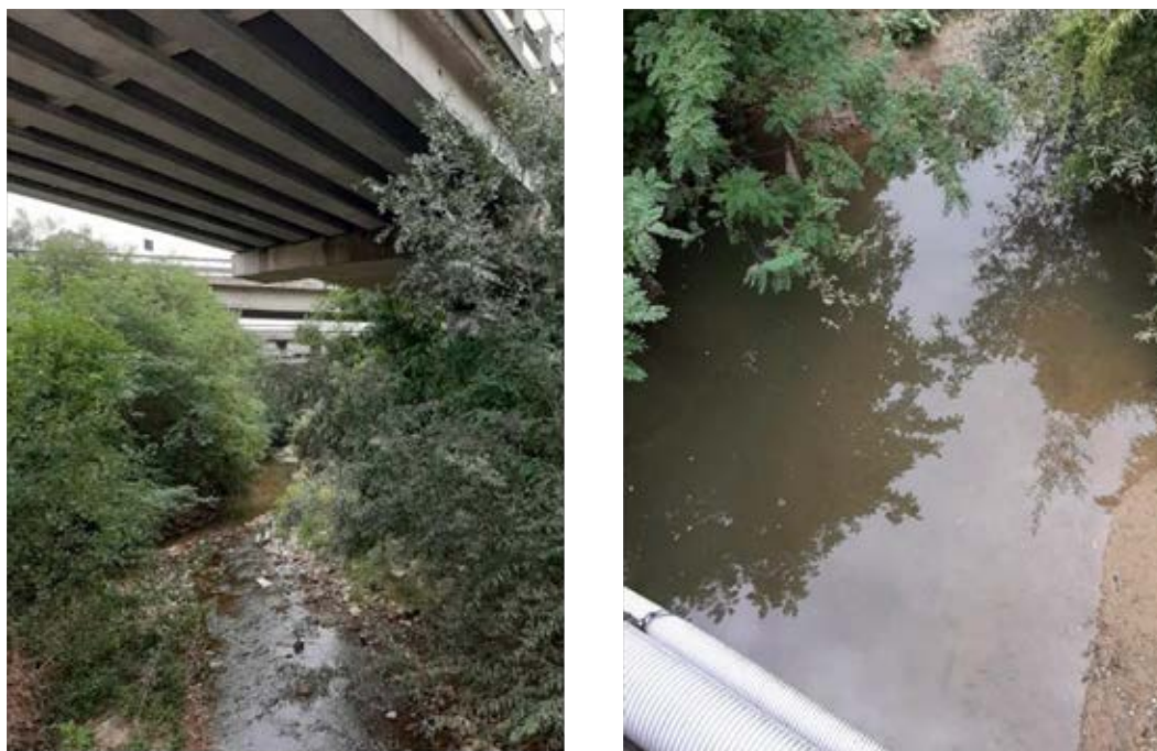
Figura 224 - Terzo attraversamento su ponte T. Tressa al di sotto dello svincolo di Tangenziale Ovest in loc. Cerchiaia
