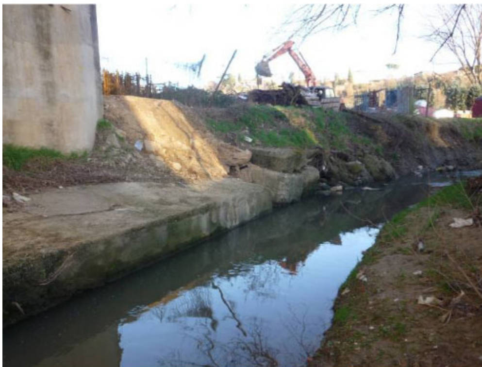
Figura 232 - Interferenza pile Viadotto Ruffolo con T. Rilugo
