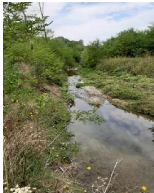
Figura 231 - Uscita T. Rilugo dal tratto tombato vista verso monte
