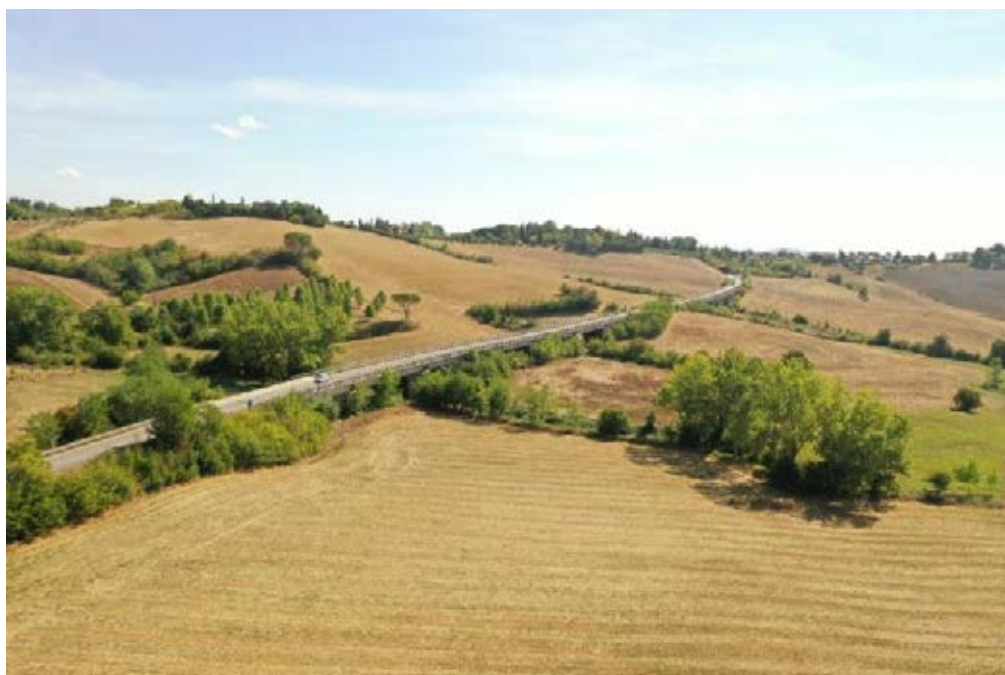
Figura 94 – Vista da sud-ovest del viadotto Casone, ben visibile la predominanza dei seminativi con elementi arborei agricoli stabili lungo i crinali nei pressi degli insediamenti e fasce ripariali eterogenee lungo i corsi di acqua
