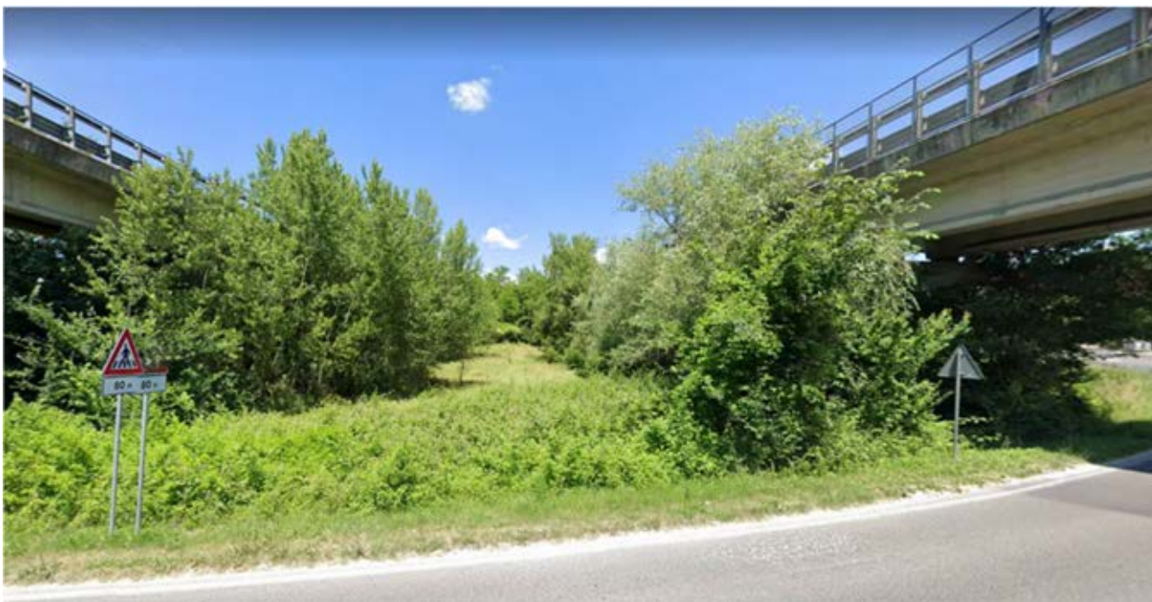
Figura 82 – Vista verso est (dir. Fano) da Str. Massettana Romana sottostante lo svincolo di Cerchiaia
