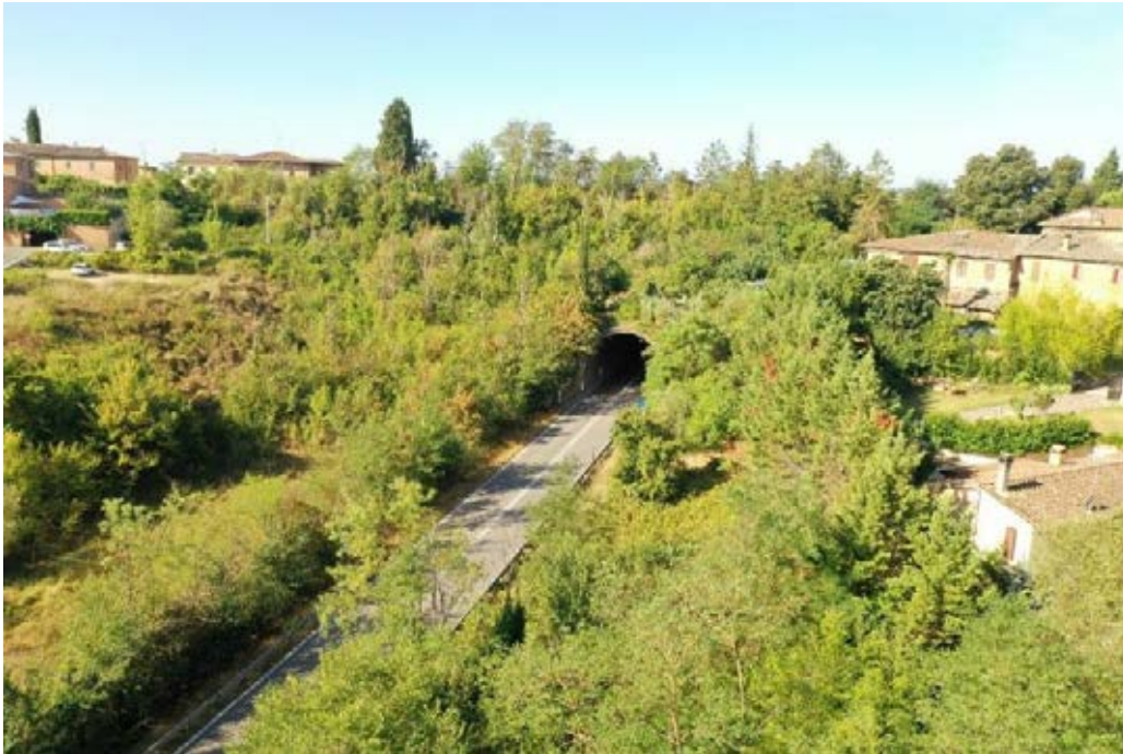
Figura 111 – Vista aerea (dir. Firenze) dell'imbocco est della galleria di S. Lazzerò con piante ornamentali, spesso conifere, afferenti a parchi privati
