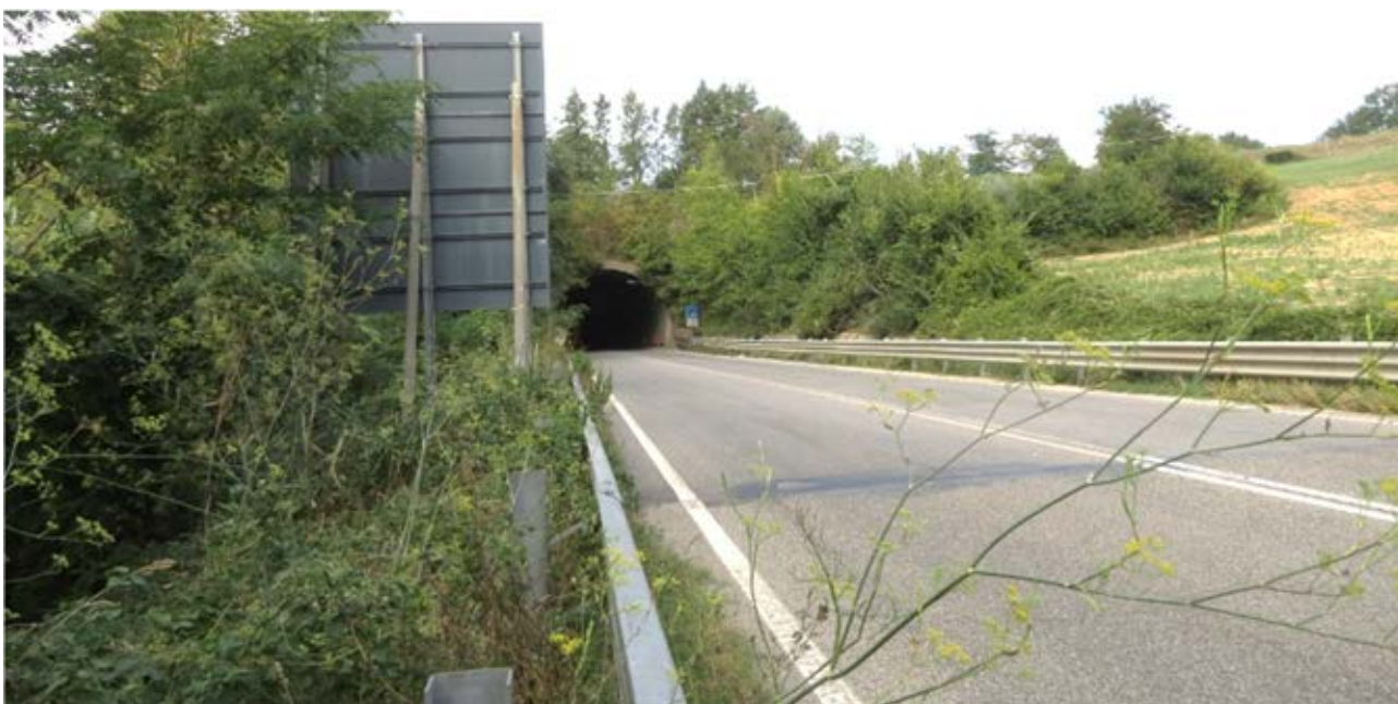
Figura 132 – evidenze di collisione con fauna in attraversamento (presumibilmente tasso).
