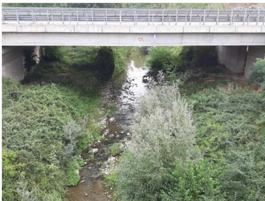
Figura 240 - Attraversamento del Torrente Bozzone su viadotto della SS 73 Siena-Bettolle - vista da Strada del Ruffolo
