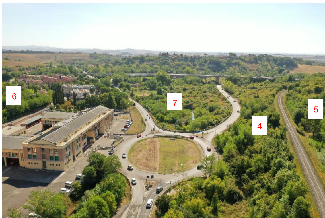
Figura 97 – Vista da ovest verso lo svincolo di Ruffolo. Nel primo piano la rotonda “dei vigli del fuoco”. Fasce arboreo arbustive alte anche nelle aree intercluse tra la ferrovia Empoli – Siena -Chiusi e la traversa Romana-Aretina
