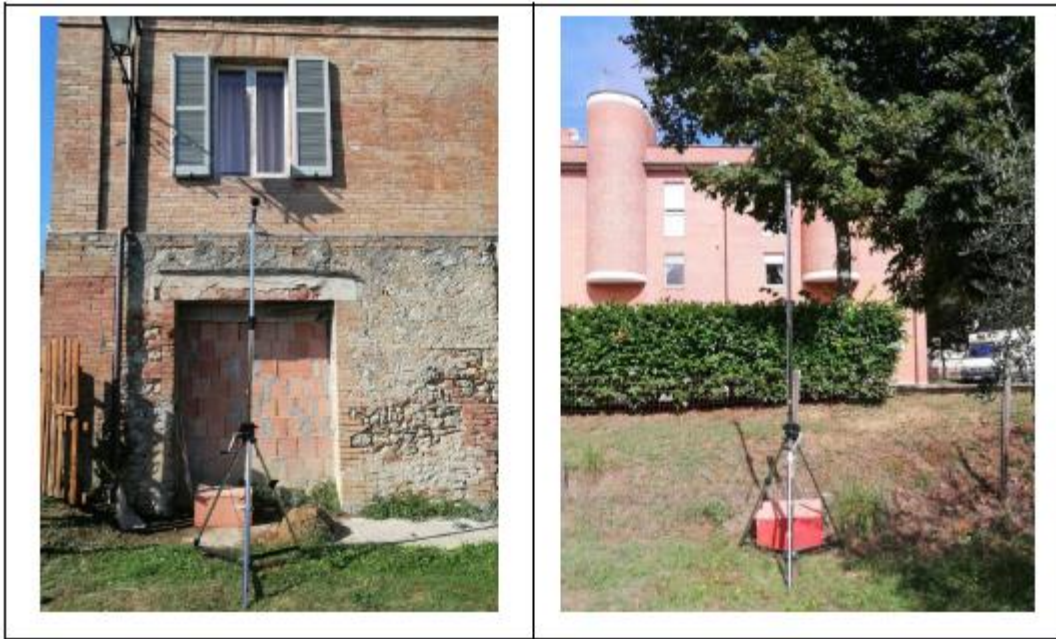
Figura 10 – Foto 1, 2 – Postazioni di misura S1, S2
