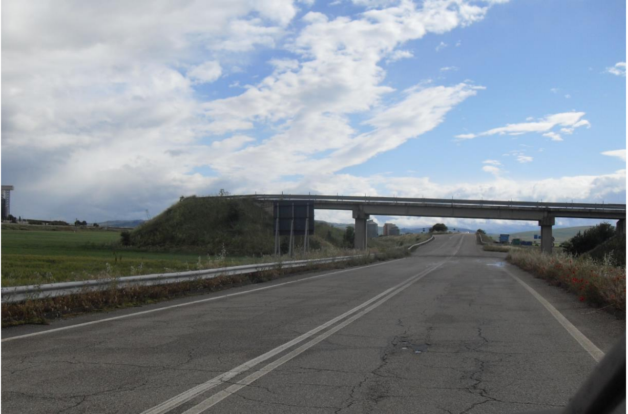
Vista della viabilità d'accesso
