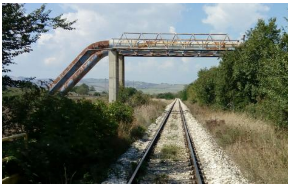
Figura 33 - Ponte tubo al km 6+306 – stato di fatto
