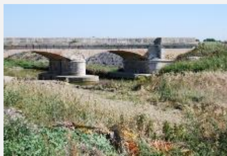
Figura 129 - Foto dell’attraversamento della ferrovia sul Torrente Cervaro (fonte: foto propria)
