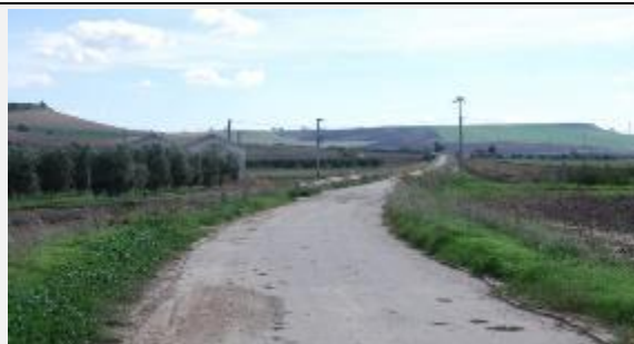
Figura 150 - Foto del tratturo che interseca la ferrovia al Km 25+500 circa, nel comune di Ascoli Satriano (fonte: foto propria).
