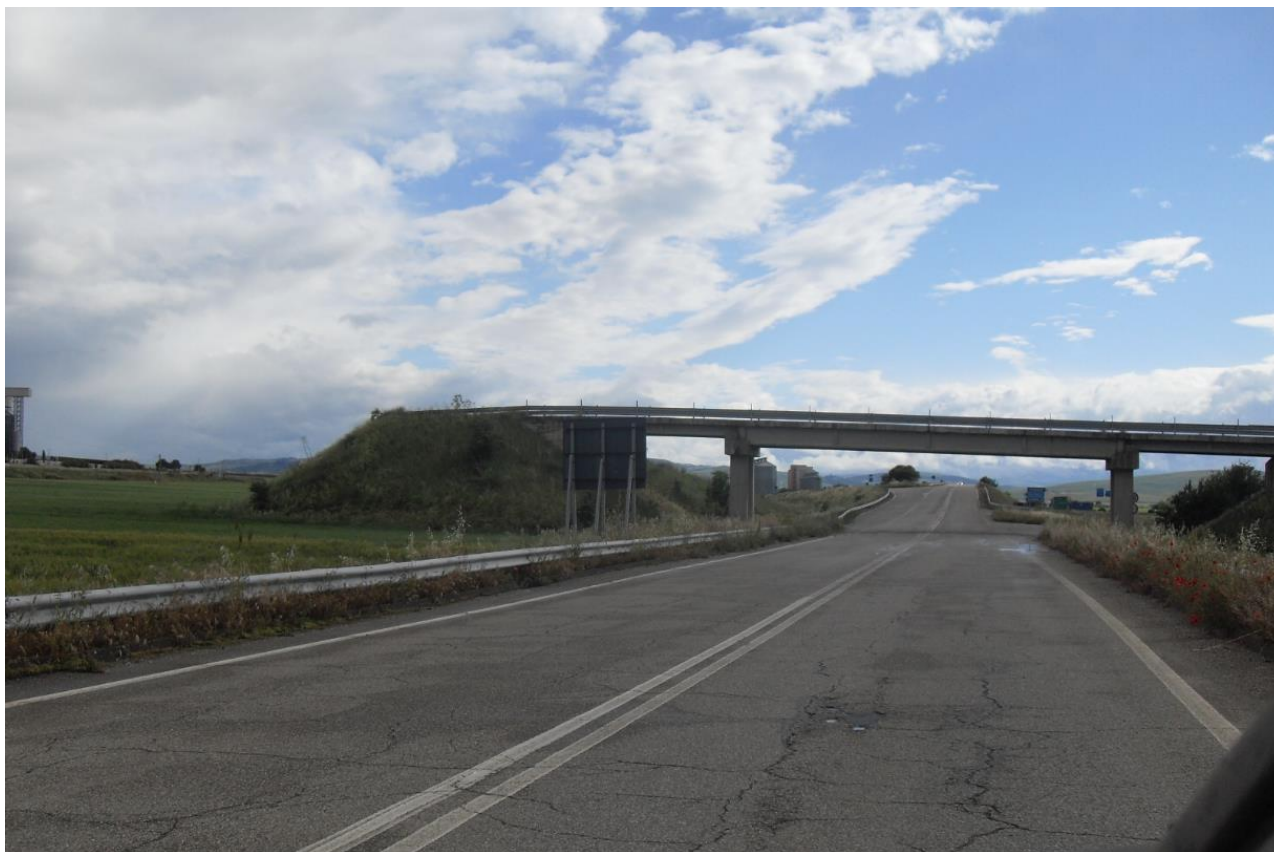
Vista della viabilità d'accesso
