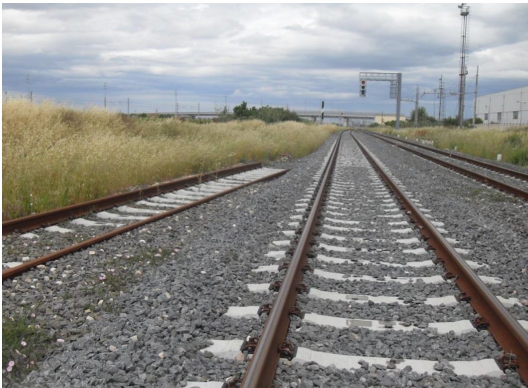
Foto 2 (vista zona deviatoio da ripristinare)
