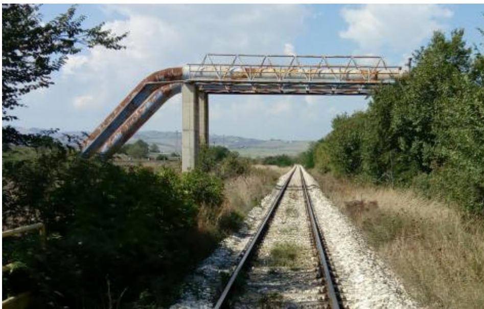
Figura 33 - Ponte tubo al km 6+306 – stato di fatto
