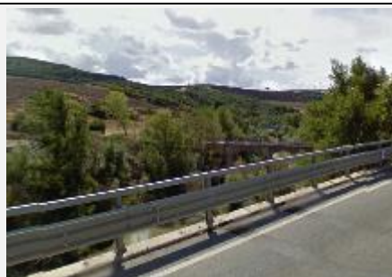
Figura 133 - Foto dell'intersezione tra la linea ferroviaria e il fiume Ofanto al Km 49+600 circa, nel Comune di Rocchetta Sant'Antonio (fonte Google Earth).
