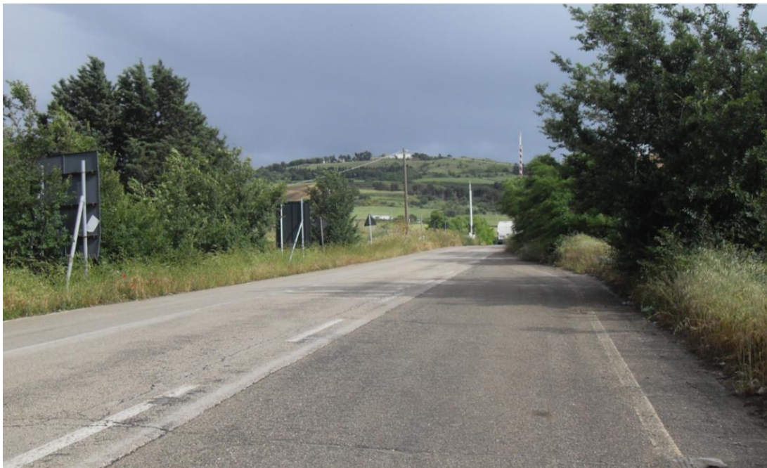
Vista della viabilità d'accesso (PL sulla SP105)
