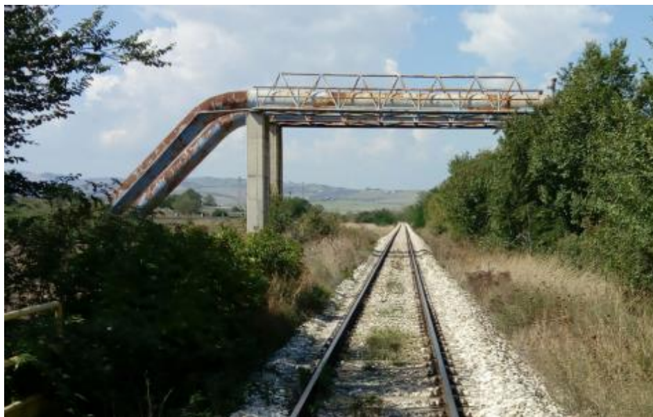
Figura 33 - Ponte tubo al km 6+306 – stato di fatto
