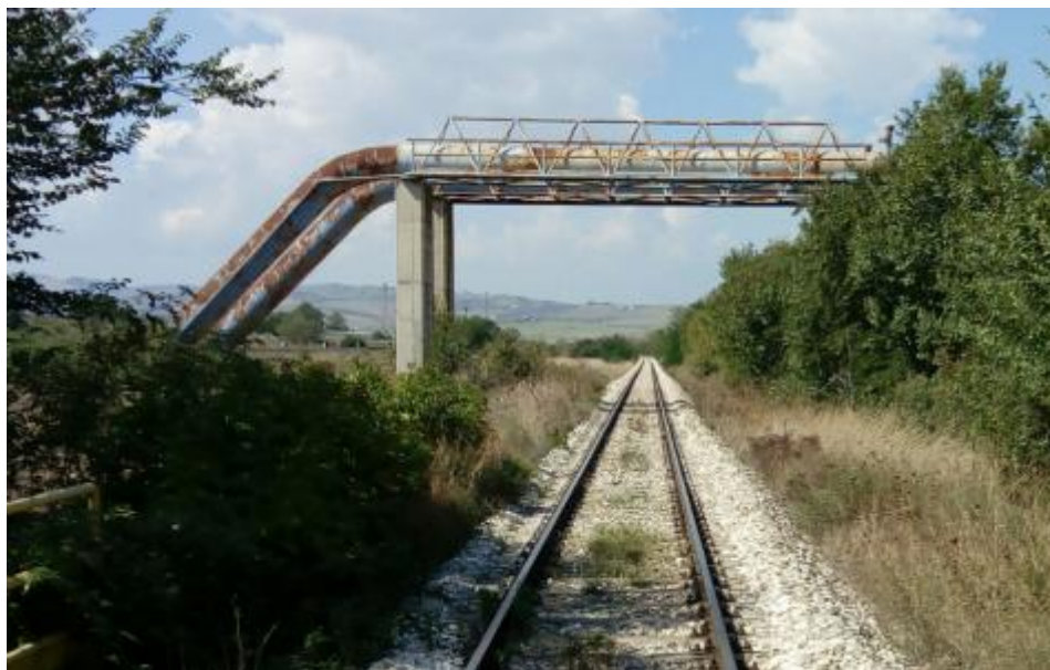
Figura 33 - Ponte tubo al km 6+306 – stato di fatto
