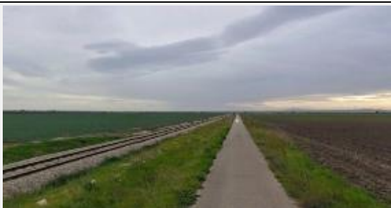
Figura 149 - Foto del tratturo che costeggia parallelamente la ferrovia dal km 11+700 al Km 14, nel Comune di Foggia (fonte Google Earth).
