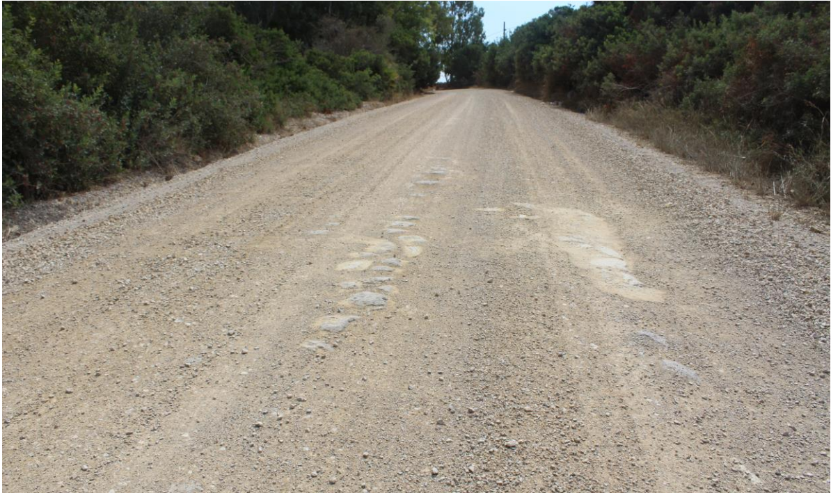
Lastricato in un tratto della Strada Vicinale Mamuntanas
