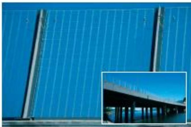
*Figura 10 - Esempio di trattamento di superfici trasparenti atto ad evitare le collisioni con l'avifauna
