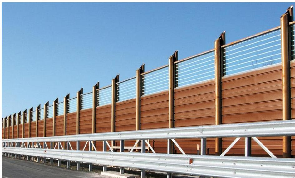
*Figura 9 – Esempio barriera mista composta da Corten e PMMA*
