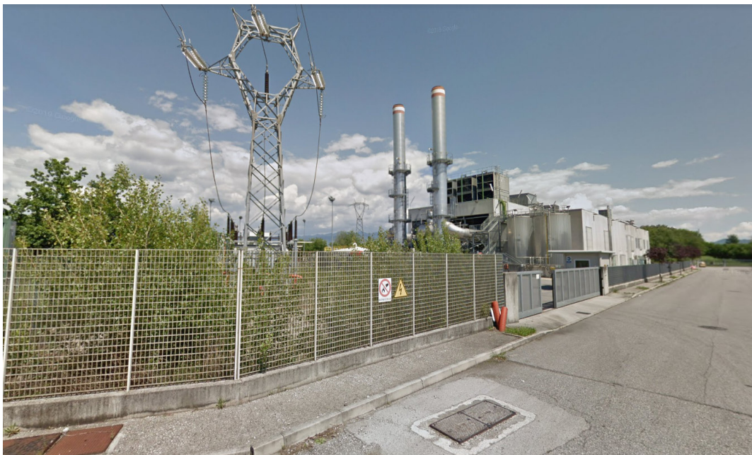
Figura 5 – vista dello stabilimento dallo spigolo ovest (Via Ressel)
