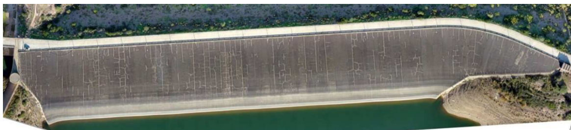
Figura 4.1.1: Diga di Medau, stato fessurativo
