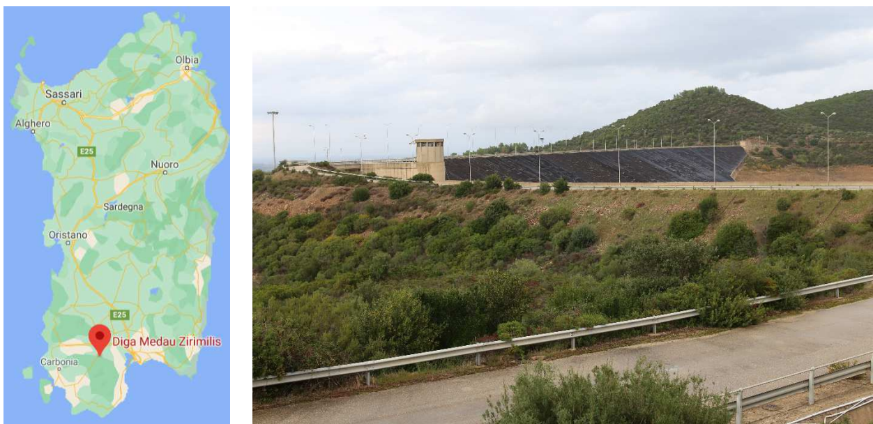
Figura 3.1.1: Localizzazione e ripresa fotografica dell'area interessata dagli interventi oggetto del presente Studio
