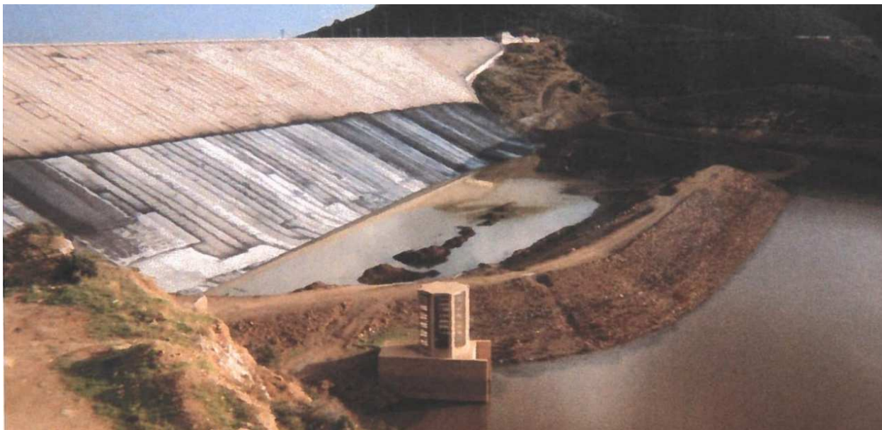
Figura 4.2.2: Avandiga durante la fase di costruzione
